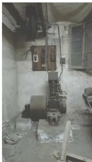
saranno demolite le tramezze in mattoni forati che attualmente delimitano i locali esistenti. Saranno rimossi gli impianti meccanici dell'ascensore in disuso e le parti impiantistiche ammalorate (scarichi fognari, impianto di riscaldamento, impianti elettrici di recente realizzazione, argano dell'ascensore e pulegge di rinvio).
