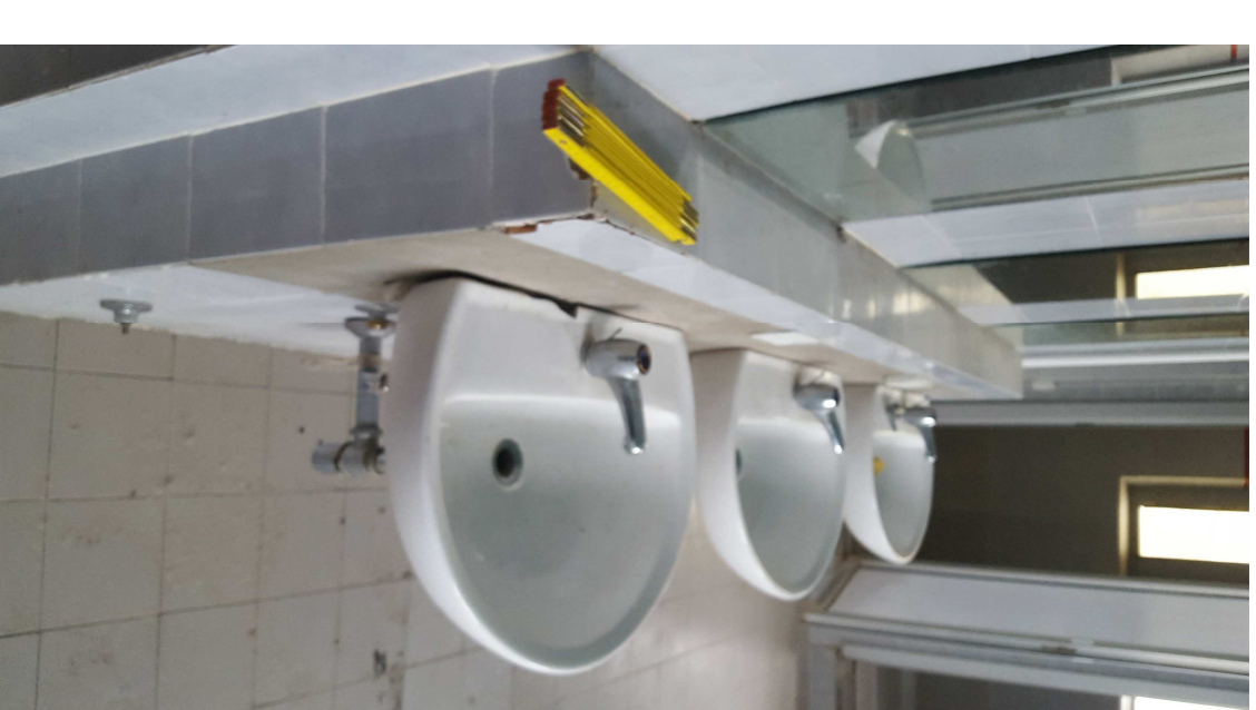
8- INTERNO SERVIZI IGIENICI
