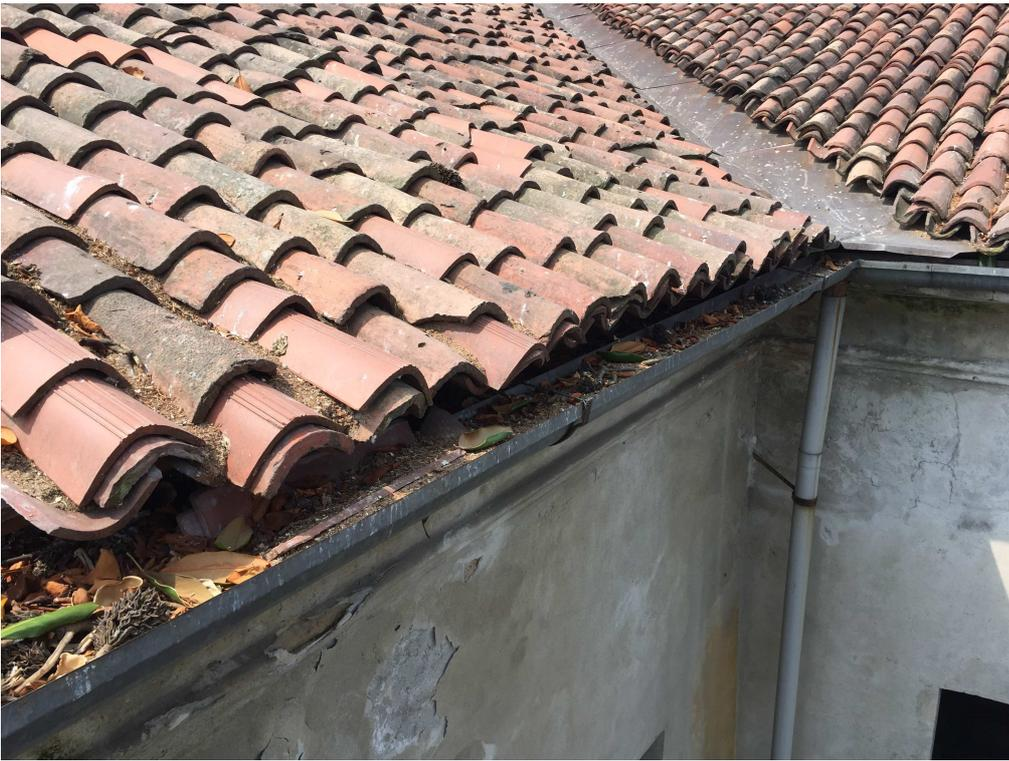
Il tetto esistente è composto dalla classica struttura con travi e capriate lignee, la copertura è realizzata in coppi e non è presente nessuno strato coibente.
