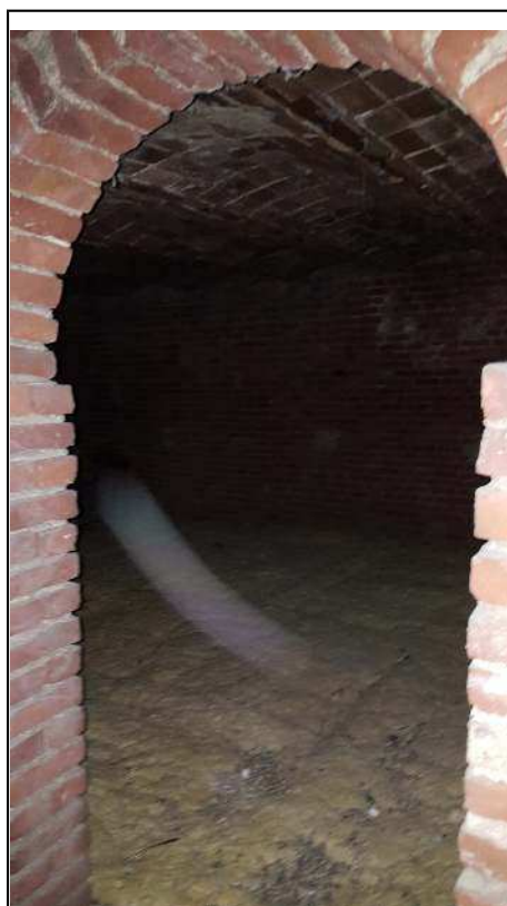
Foto 26: Vista accesso torretta.
