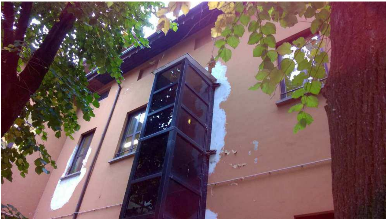
Foto 20: Vista da cortile interno: prospetto corpo OVEST.
