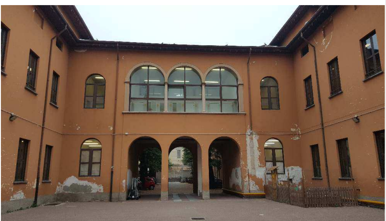
Foto11: Vista da cortile interno: prospetto corpo di collegamento trasversale prospiciente Corso Cavour.
