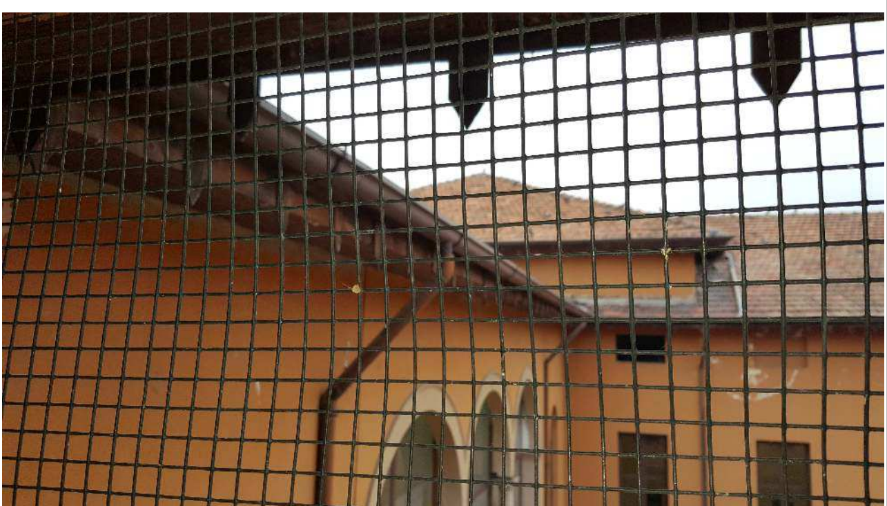
Foto 16: Vista da sottotetto corpo OVEST: dettaglio copertura prospetti interni.
