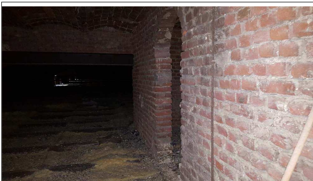
Foto 25: Vista zona ingresso dalla scala della scuola.
