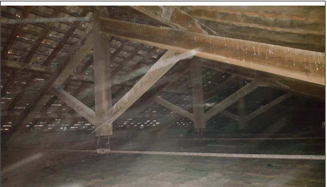
Foto 28: Vista struttura portante principale: capriate.
