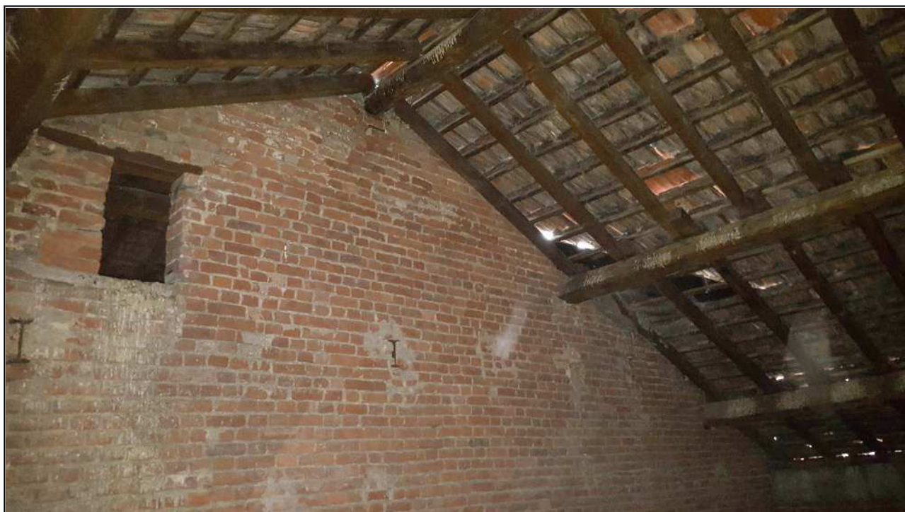
Foto 35: Vista orditura portante secondaria: terzere e travetti.
