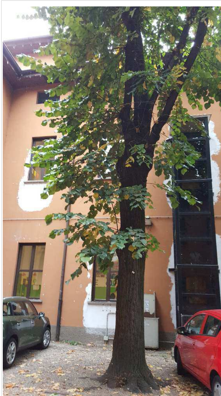
Foto 19: Vista da cortile interno: prospetto corpo OVEST.
