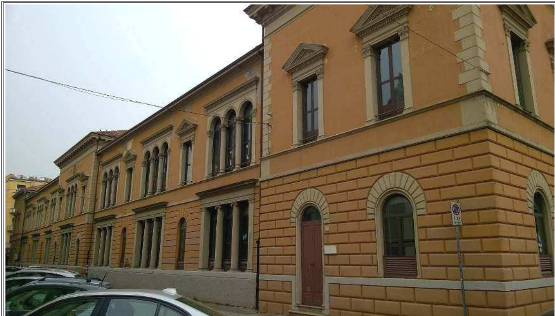
Foto 8: Vista da Via F.lli Cremona - Corpo EST
