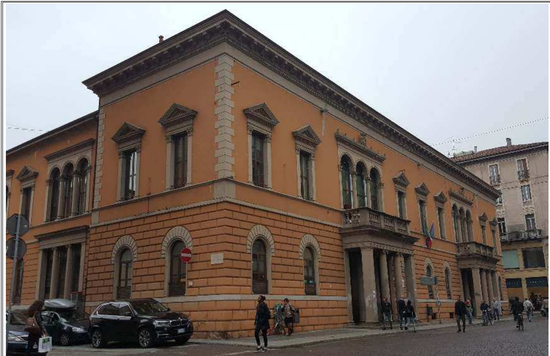
Foto 1: Vista da Corso Cavour - Corpo ingresso principale - non soggetto a intervento.
