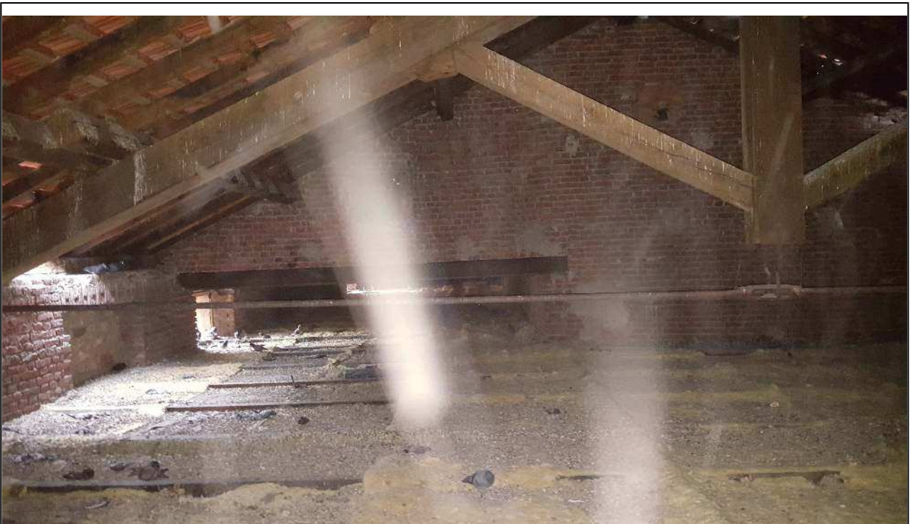
Foto 30: Vista rivestimento solaio sottotetto con lana di vetro.
