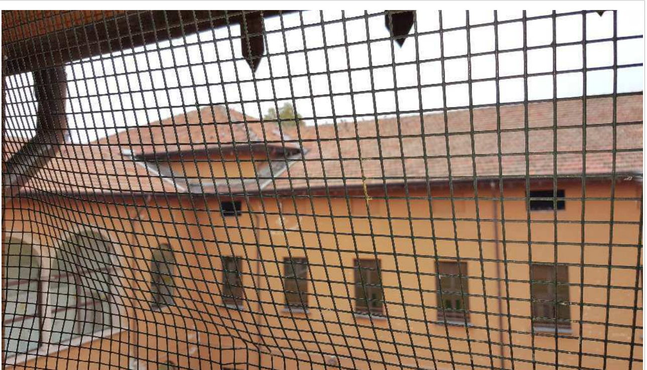
Foto 17: Vista da sottotetto corpo OVEST: dettaglio copertura prospetti interni.
