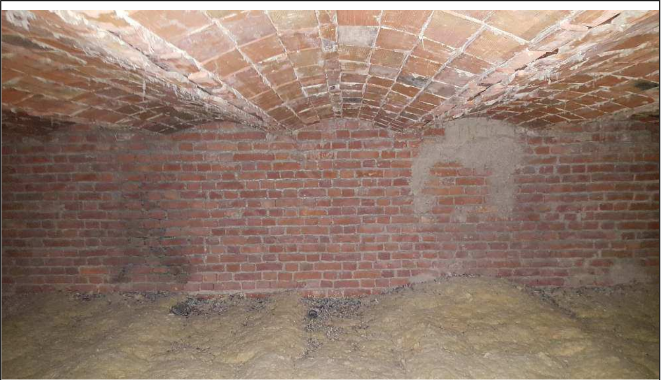
Foto 31: Vista impalcato intermedio torrette: solaio putrelle metalliche e voltini.
