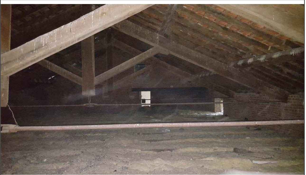
Foto 27: Vista struttura portante principale: capriate.
