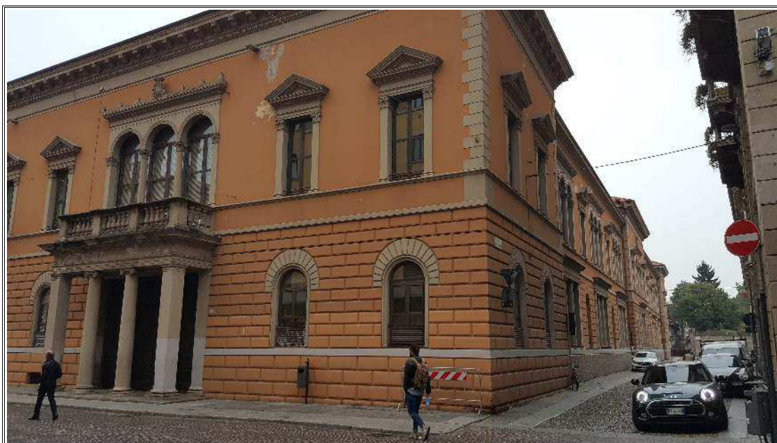
Foto 10: Vista da Corso Cavour angolo Via F.lli Cremona - Corpo EST.
