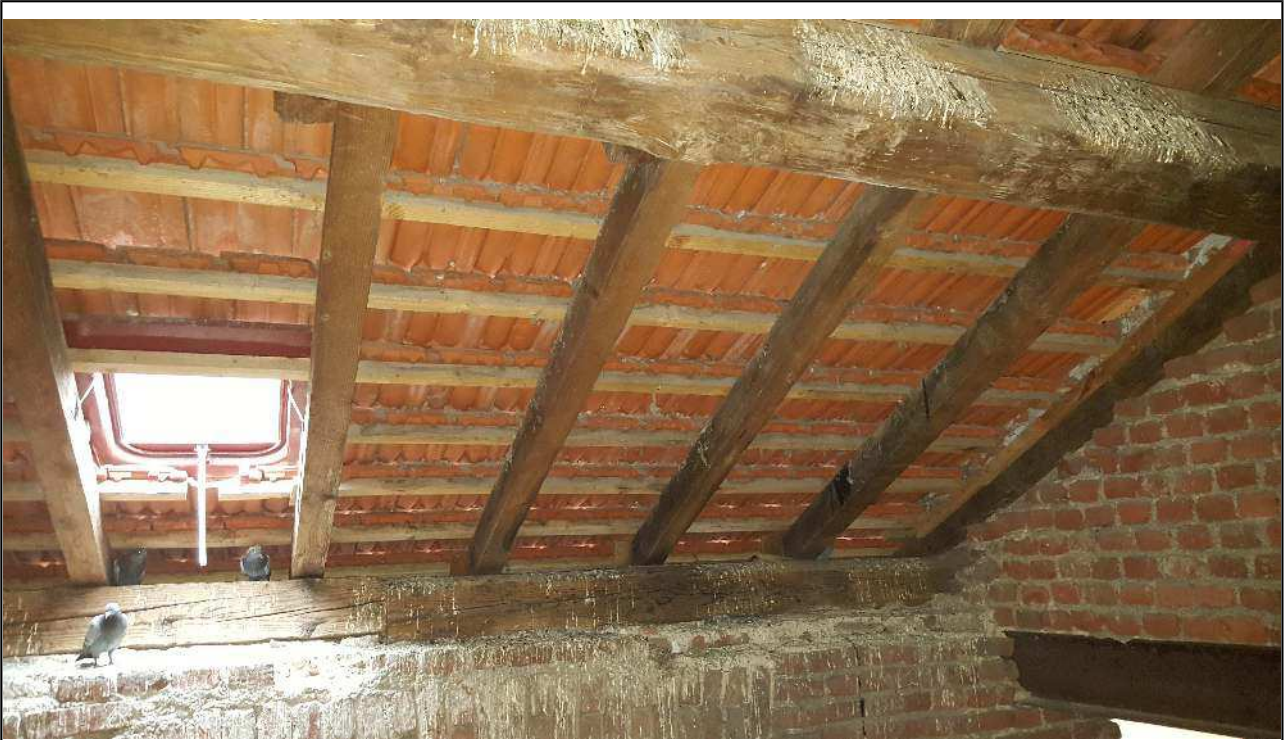
Foto 29: Vista orditura portante secondaria – particolare finestra in plexiglass da rimuovere.
