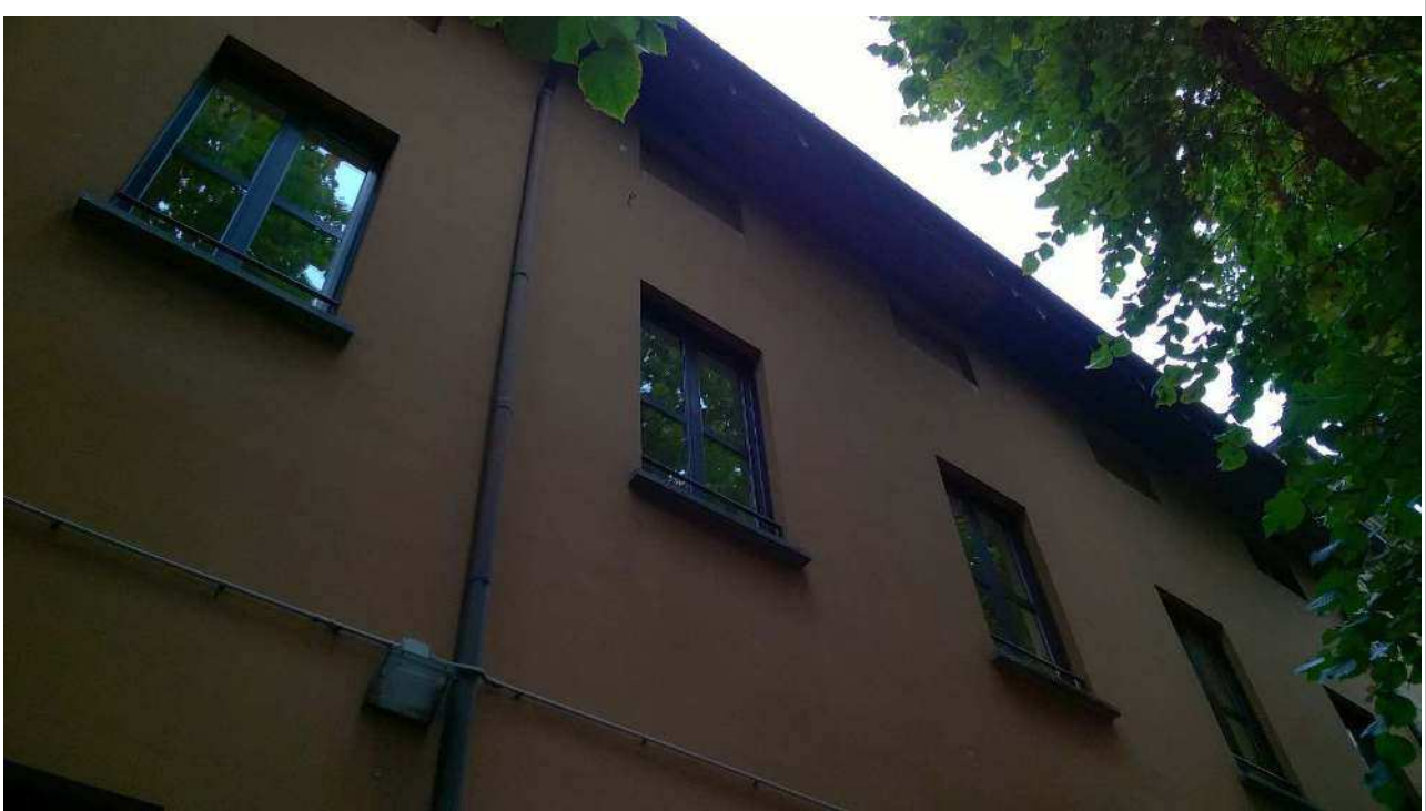
Foto 21: Vista da cortile interno: prospetto corpo OVEST.
