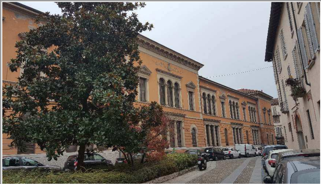
Foto 3: Vista da Via Palestro - Corpo OVEST.
