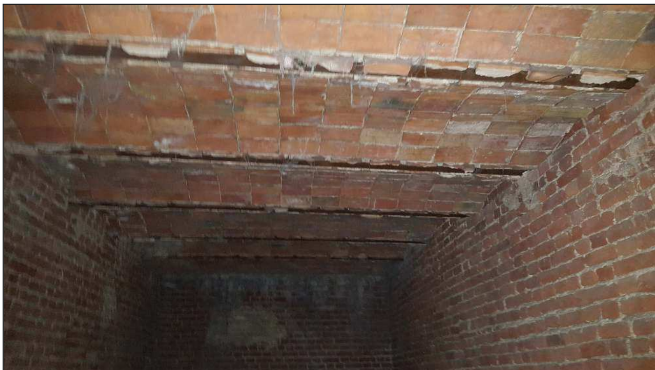
Foto 34: Vista zona ingresso – impalcato torretta vano scala: putrelle e voltine.
