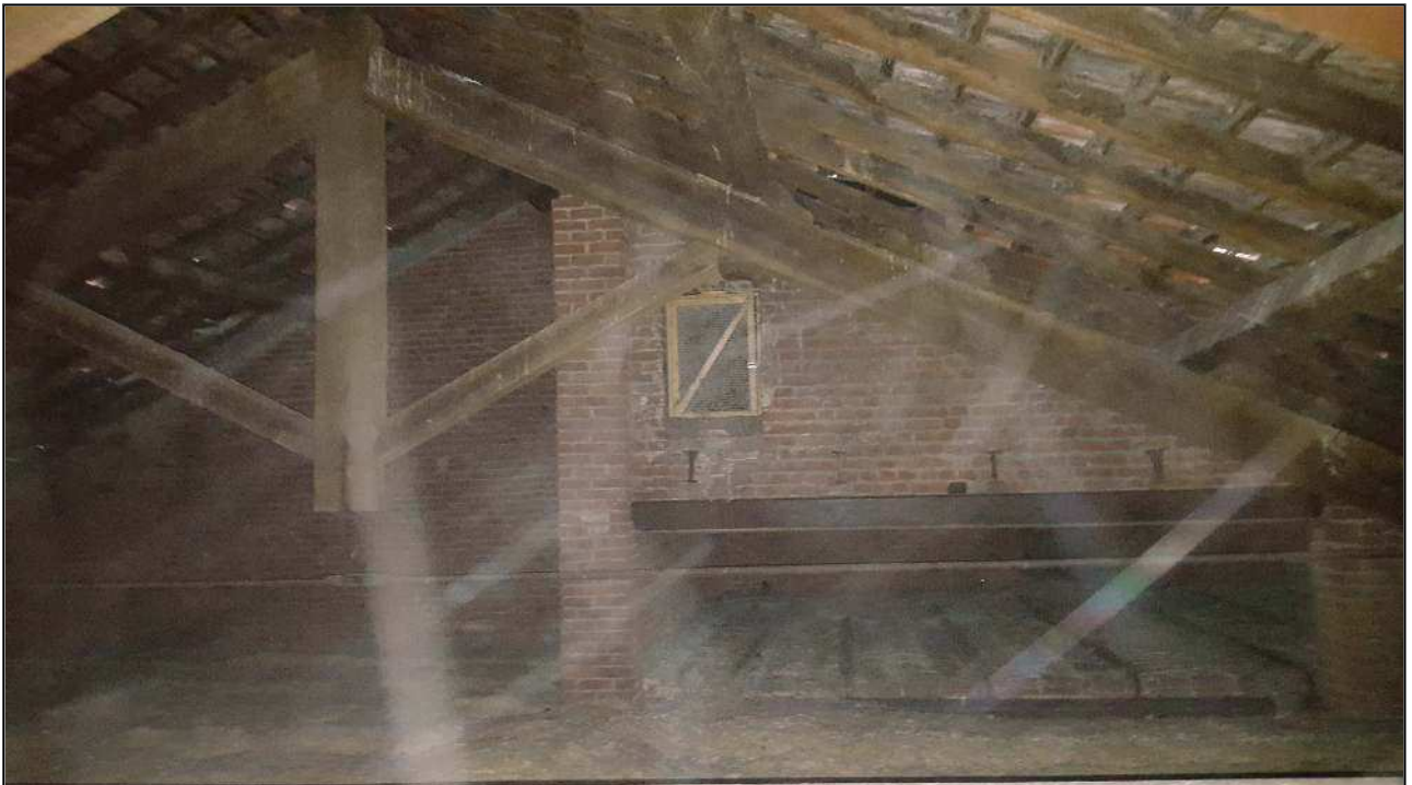
Foto 41: Vista orditura lignea primaria e secondaria.
