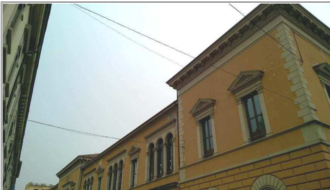
Foto 9: Vista da Via F.lli Cremona - corpo EST.
