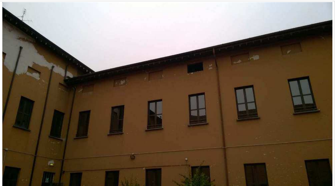
Foto12: Vista da cortile interno: prospetto corpo OVEST.
