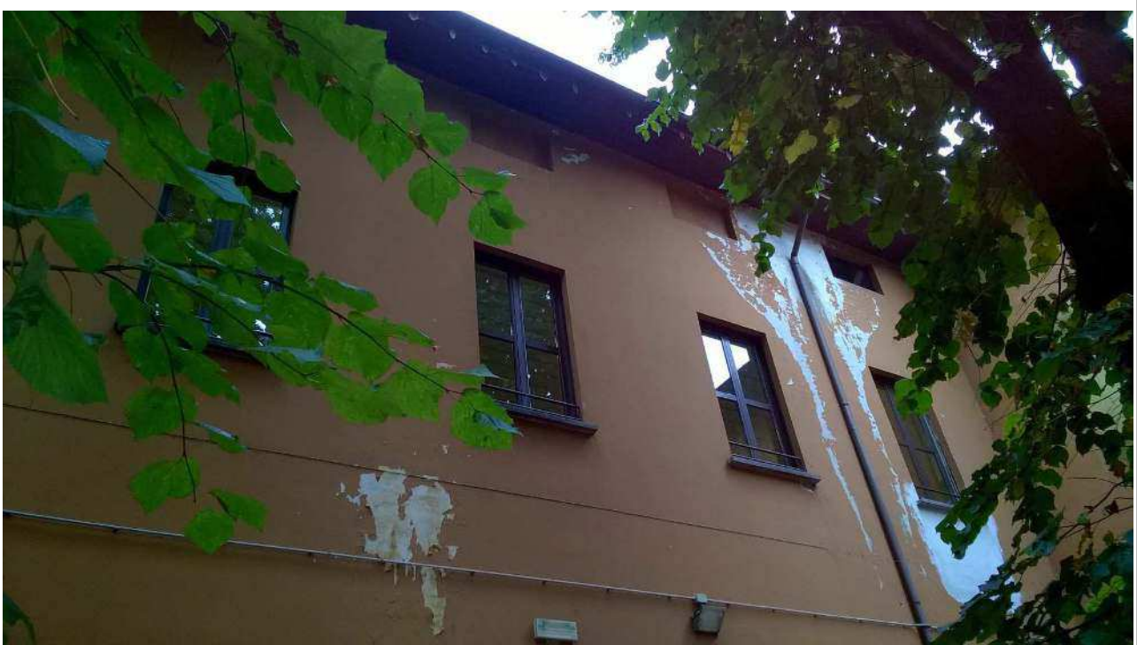
Foto 23: Vista da cortile interno: prospetto corpo EST.
