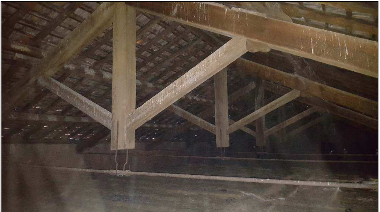
Foto 40: Vista orditura lignea primaria e secondaria.
