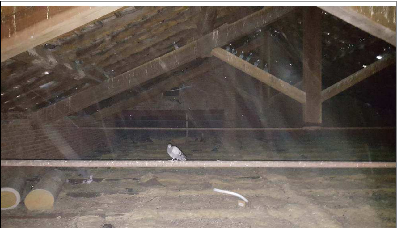
Foto 32: Vista orditura lignea primaria e secondaria.
