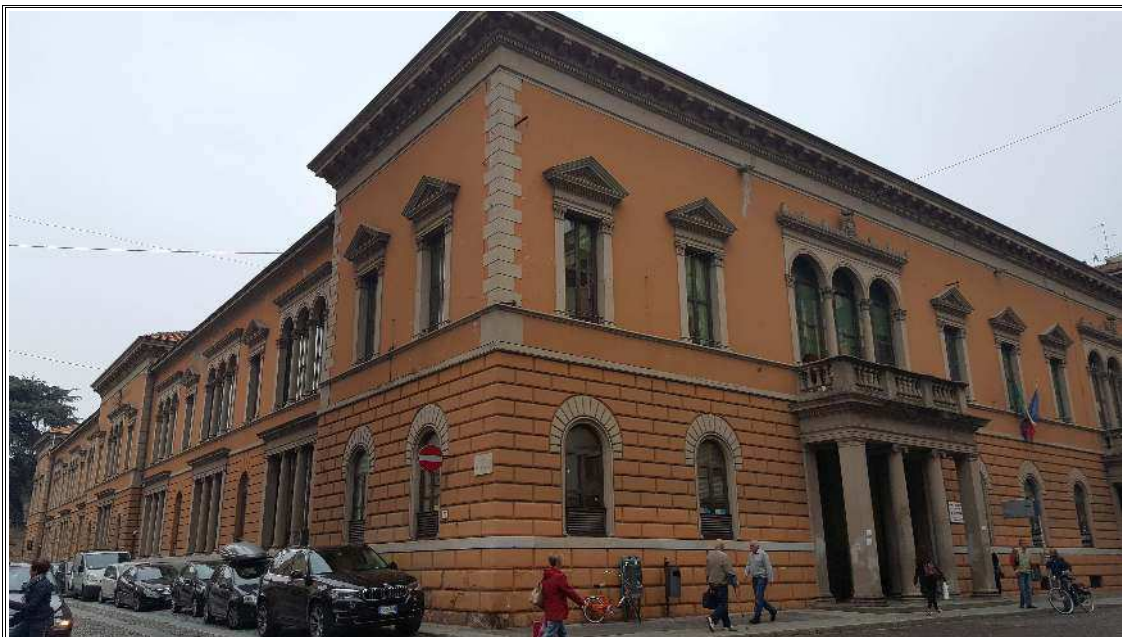
Foto 2: Vista da Corso Cavour angolo Via Palestro - Corpo OVEST.
