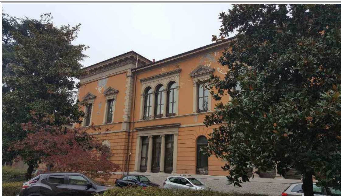
Foto 4: Vista da Via Palestro - Corpo OVEST.
