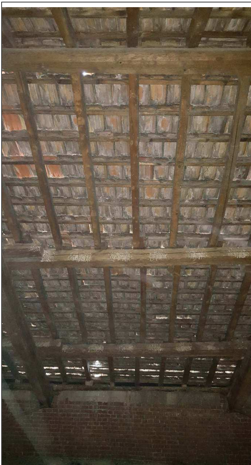
Foto 33: Particolare campata tra due capriate: orditura secondaria e piccola orditura.
