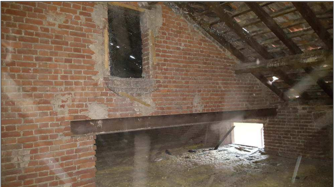
Foto 38: Vista zona torretta centrale.
