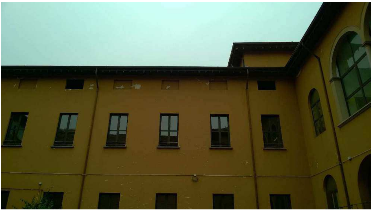
Foto 13: Vista da cortile interno: prospetto corpo OVEST.
