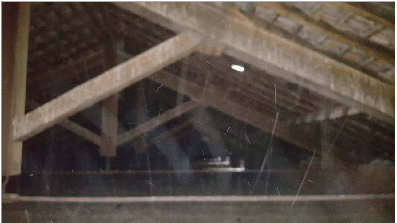
Foto 36: Vista struttura portante principale: capriate.
