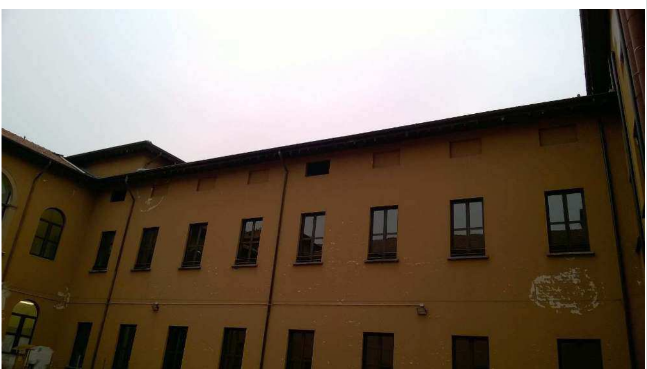
Foto 14: Vista da cortile interno: prospetto corpo EST.
