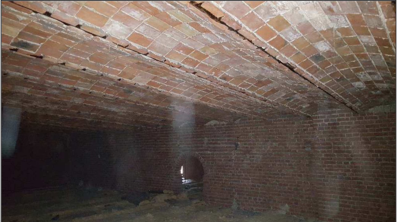
Foto 39: Vista impalcato intermedio torretta centrale: solaio putrelle metalliche e voltini.
