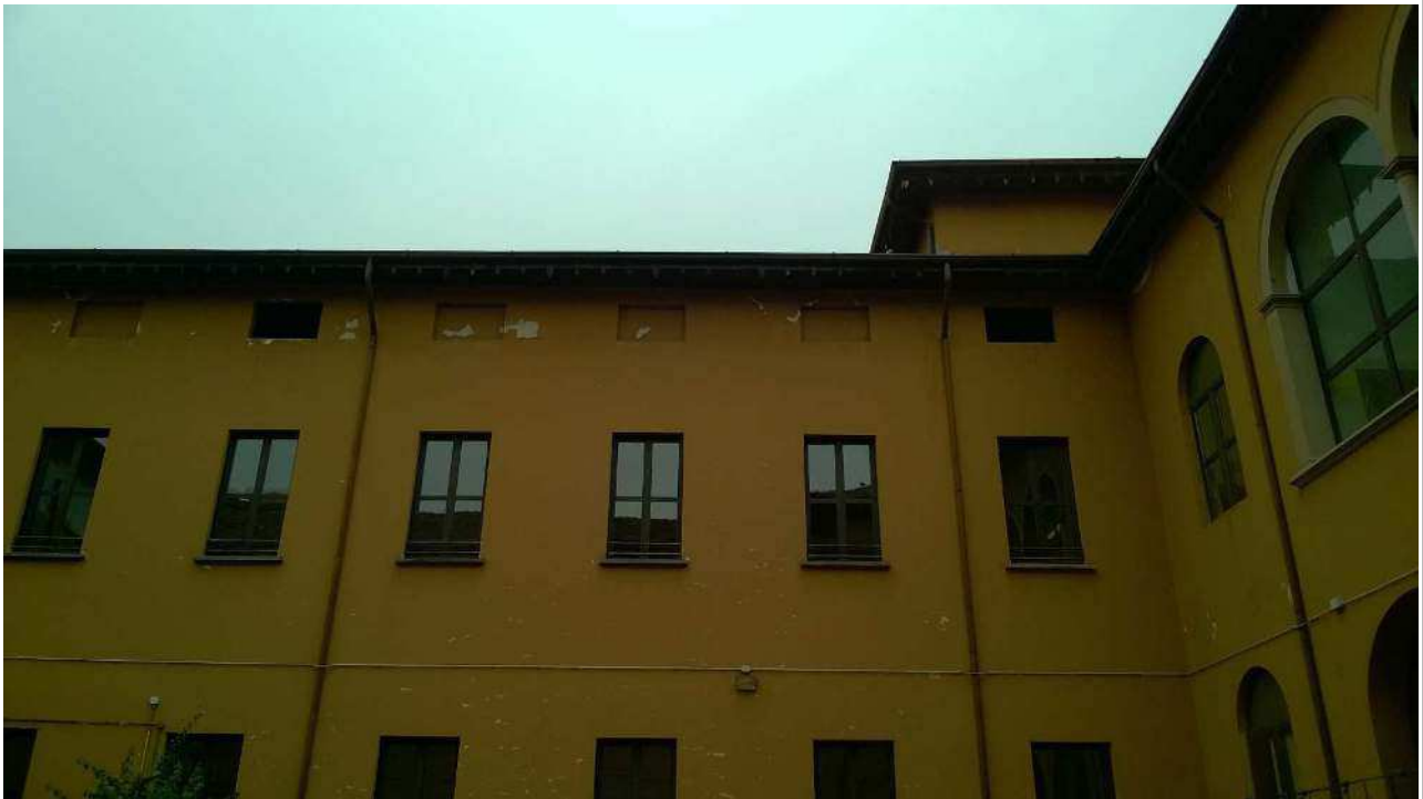
Foto 15: Vista da cortile interno: prospetto corpo EST.
