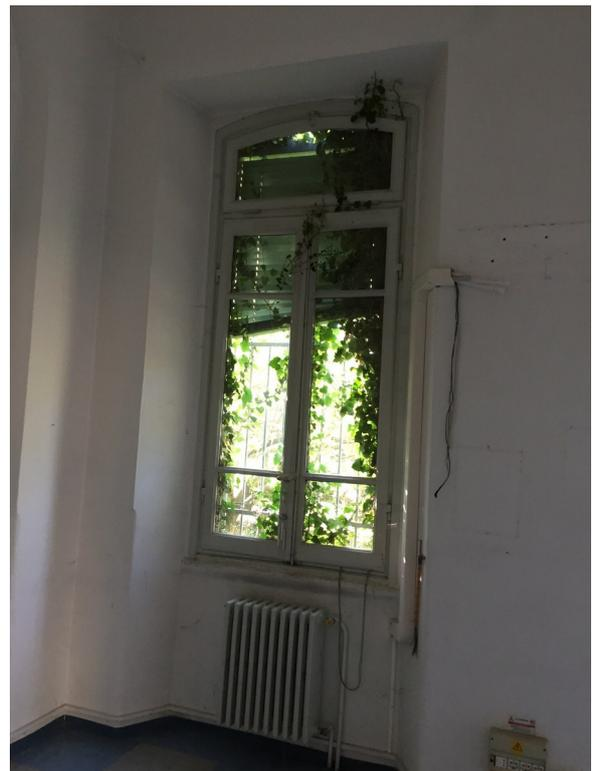
I serramenti posti sul lato sud al contrario si presentano fortemente deteriorati, hanno dimensione di 110 cm larghezza per 210 cm di altezza con un sopraluce ad arco di dimensioni 110 cm di larghezza per 60 cm di altezza nel punto più alto, sono in materiale ligneo fortemente deteriorato dalle intemperie e vedono applicato un vetro singolo.
