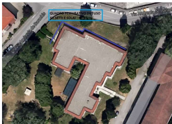
FIGURA 1 - Individuazione zona interessata da quadro fessurativo
