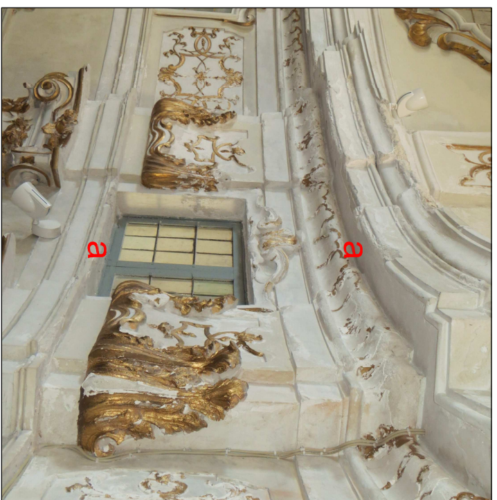
Cornice deteriorata
