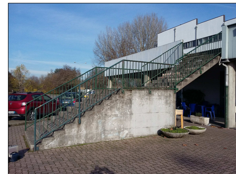
SCALA DI SICUREZZA "A" (DX) - Vista laterale (Sud-Est)
