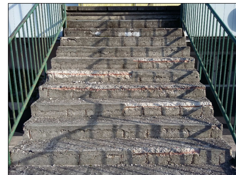
SCALA DI SICUREZZA "A" (DX) - Gradini superiori
