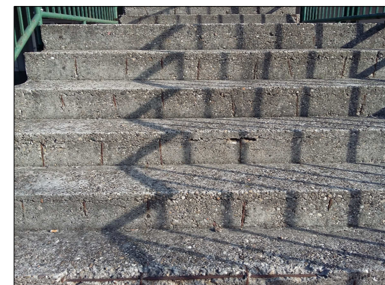
SCALA DI SICUREZZA "B" (SX) - Gradini inferiori
