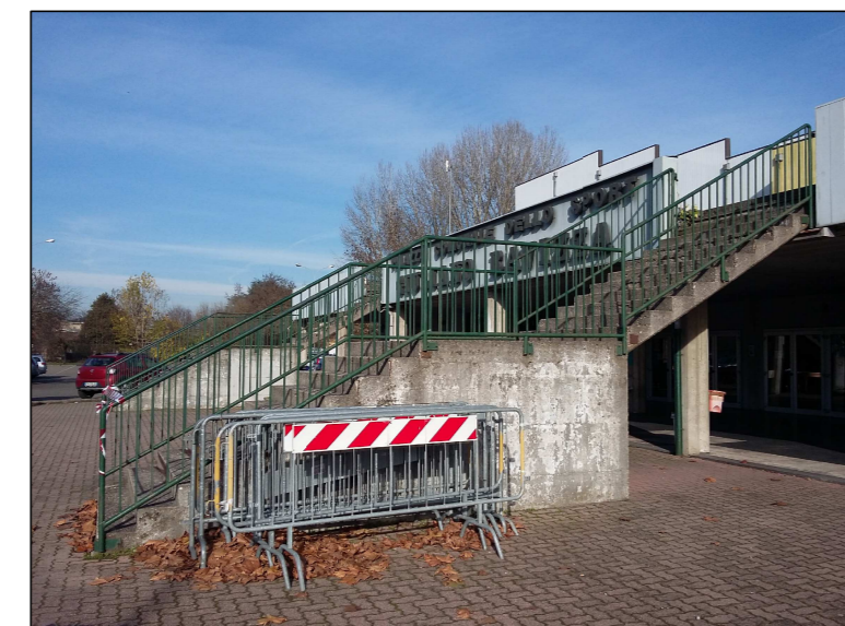
SCALA DI SICUREZZA "B" (SX) - Vista laterale (Sud-Est)
