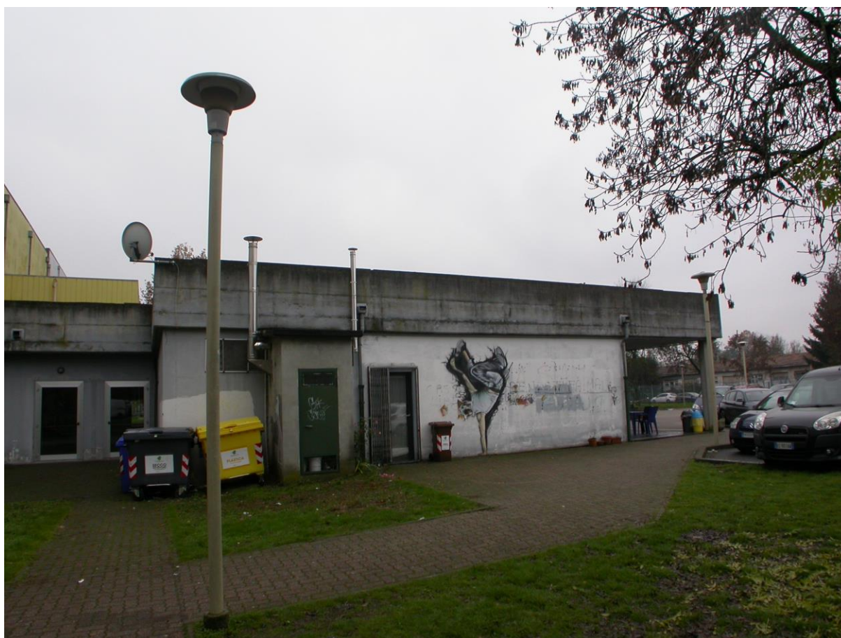
Foto n° 4 – PROSPETTO NORD-OVEST - part.
