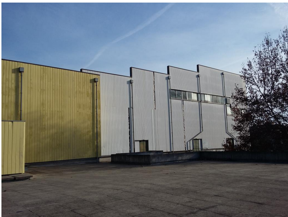
Foto n° 34 – Terrazza - vista verso il lato SUD-EST
