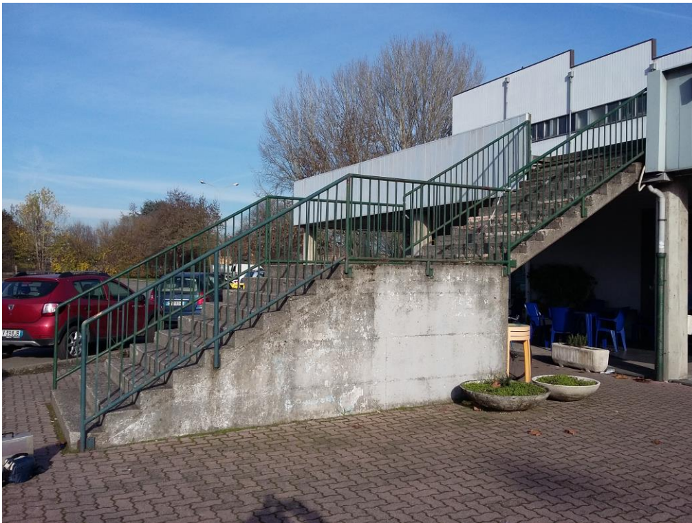
Foto n° 17 – Scala di sicurezza "A" (Dx) - vista laterale (Sud-Est)
