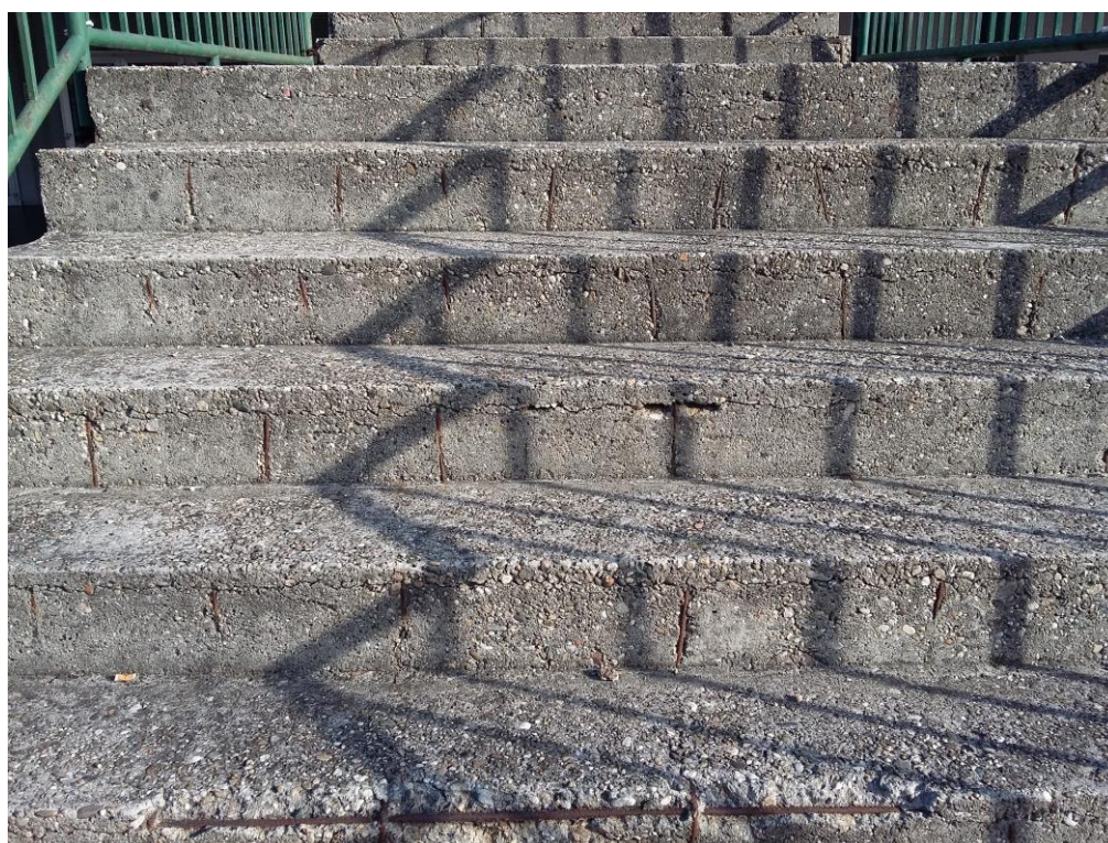
Foto n° 20 – Scala di sicurezza "B" (Sx) - gradini inferiori
