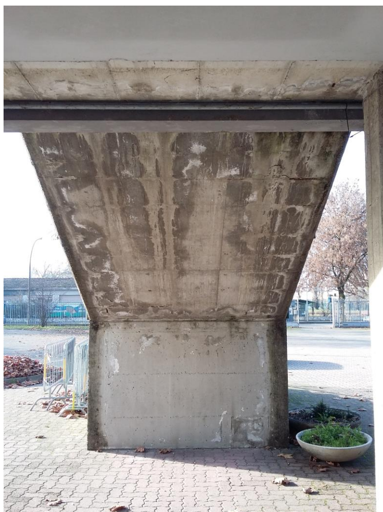
Foto n° 24 – Scala di sicurezza "B" (Sx) - vista posteriore soletta a sbalzo
