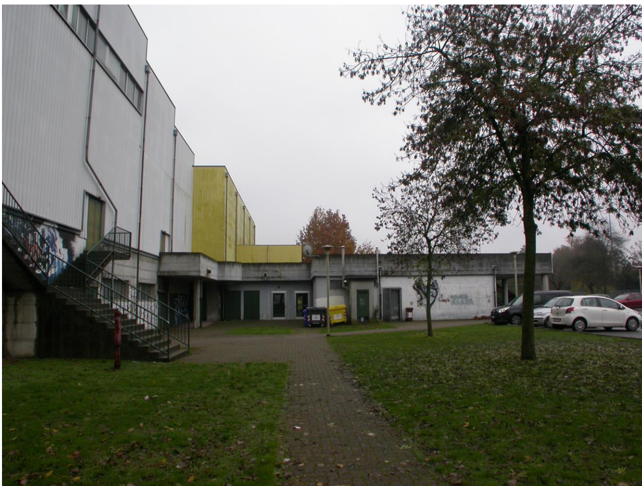
Foto n° 2 – PROSPETTO NORD-OVEST - Terrazza
