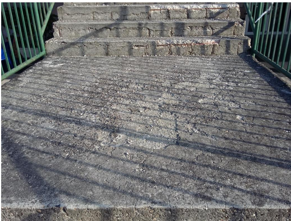
Foto n° 15 – Scala di sicurezza "A" (Dx) - pianerottolo intermedio
