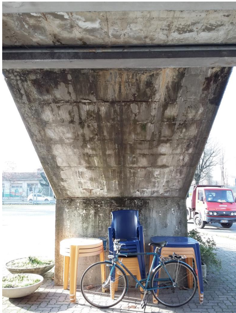
Foto n° 18 – Scala di sicurezza "A" (Dx) - vista posteriore soletta a sbalzo
