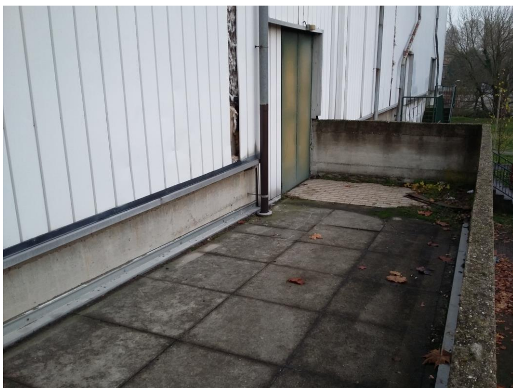
Foto n° 36 – Terrazza – vista dell'uscita di sicurezza a SUD-EST
