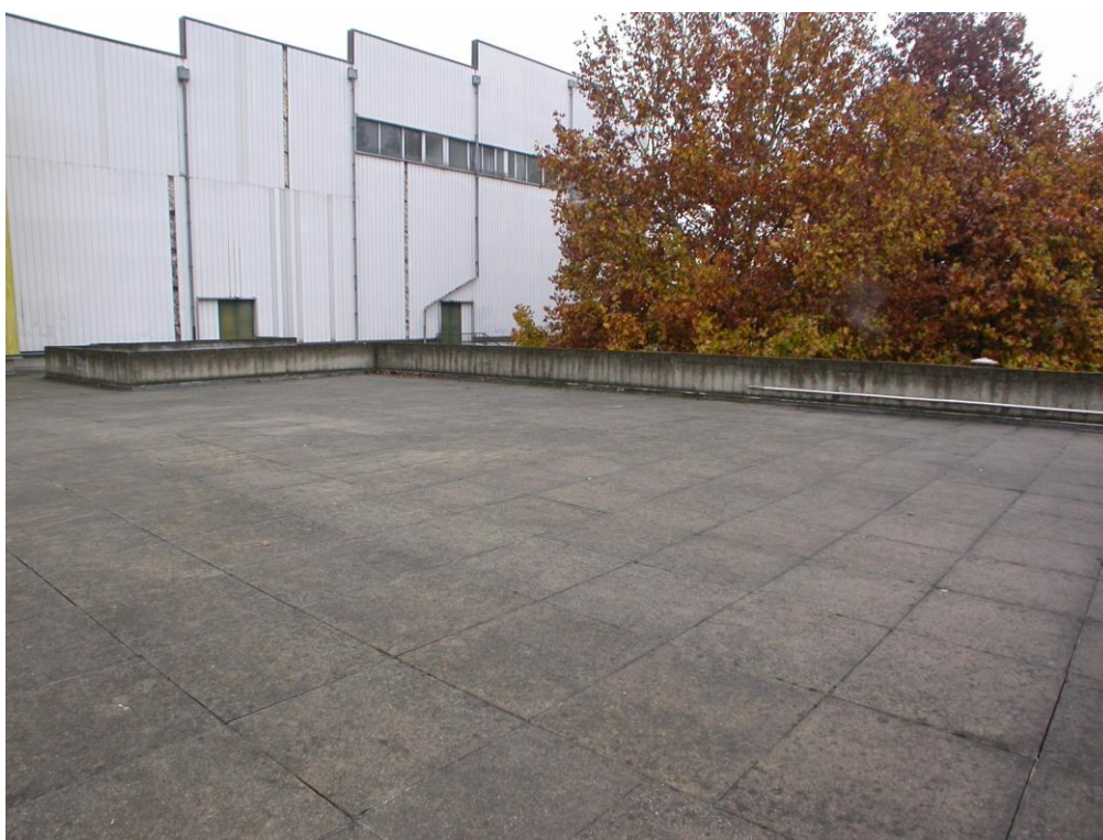
Foto n° 33 – Terrazza - vista verso il lato SUD-EST
