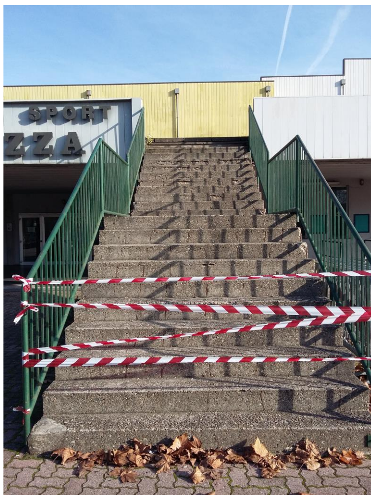
Foto n° 19 – Scala di sicurezza "B" (Sx) - vista frontale
