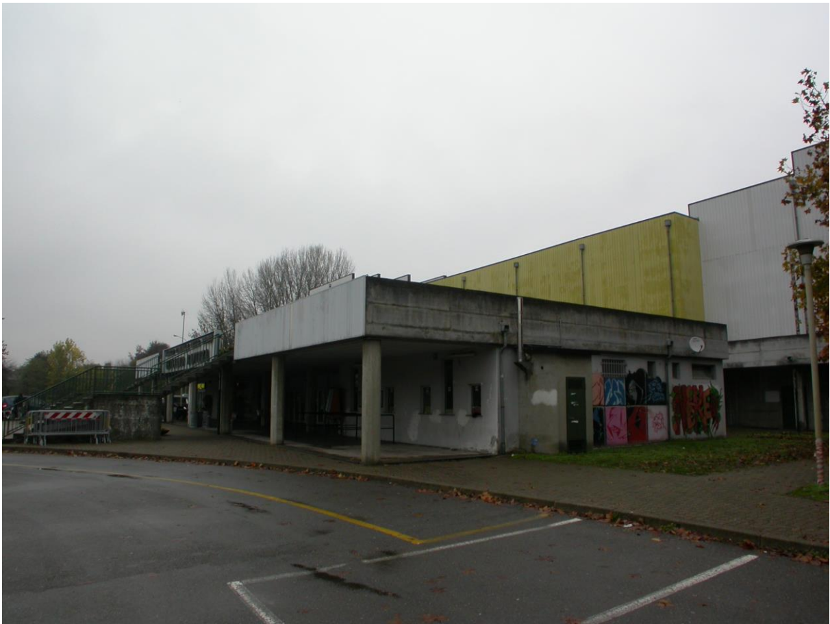
Foto n° 9 – PROSPETTO angolo SUD-OVEST - SUD-EST
