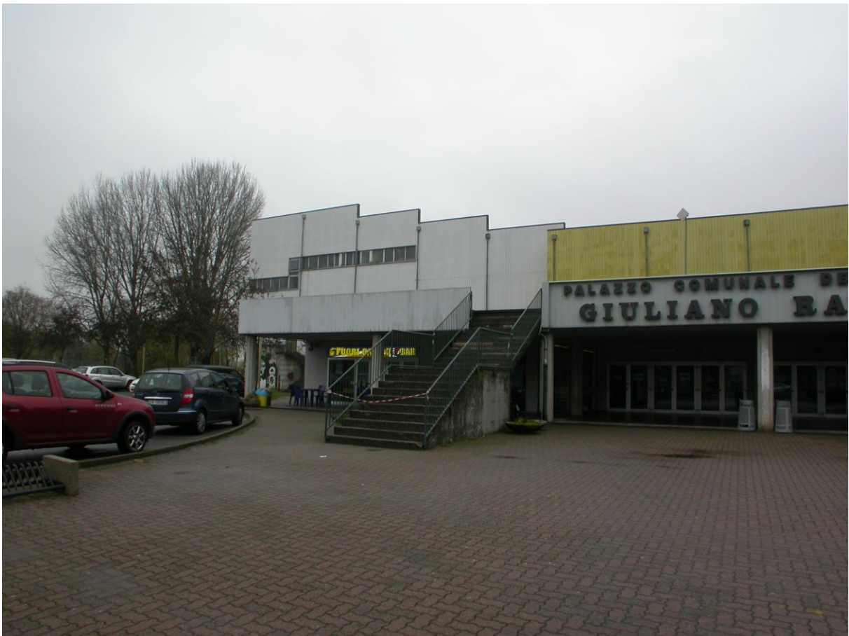
Foto n° 6 – PROSPETTO SUD-OVEST - Scala DX di accesso alla Terrazza
