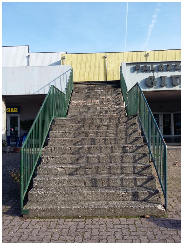
Foto n° 13 – Scala di sicurezza "A" (Dx) - vista frontale
