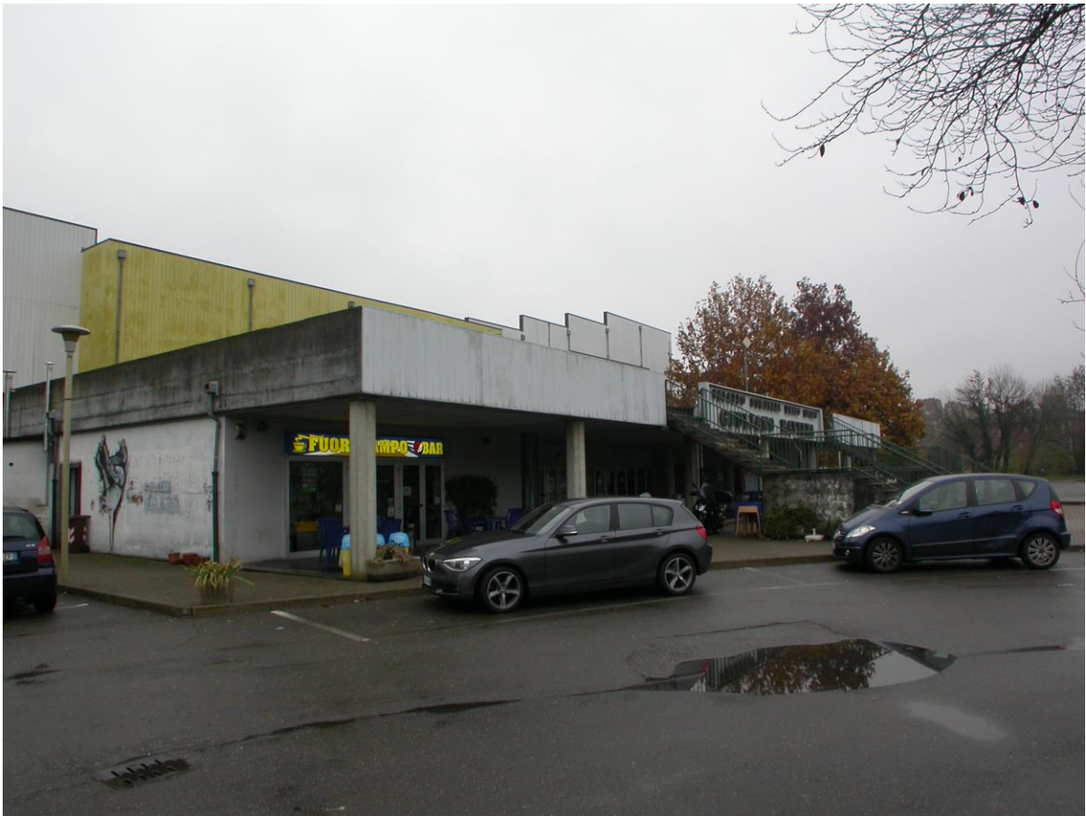
Foto n° 5 – PROSPETTO angolo NORD-OVEST - SUD-OVEST
