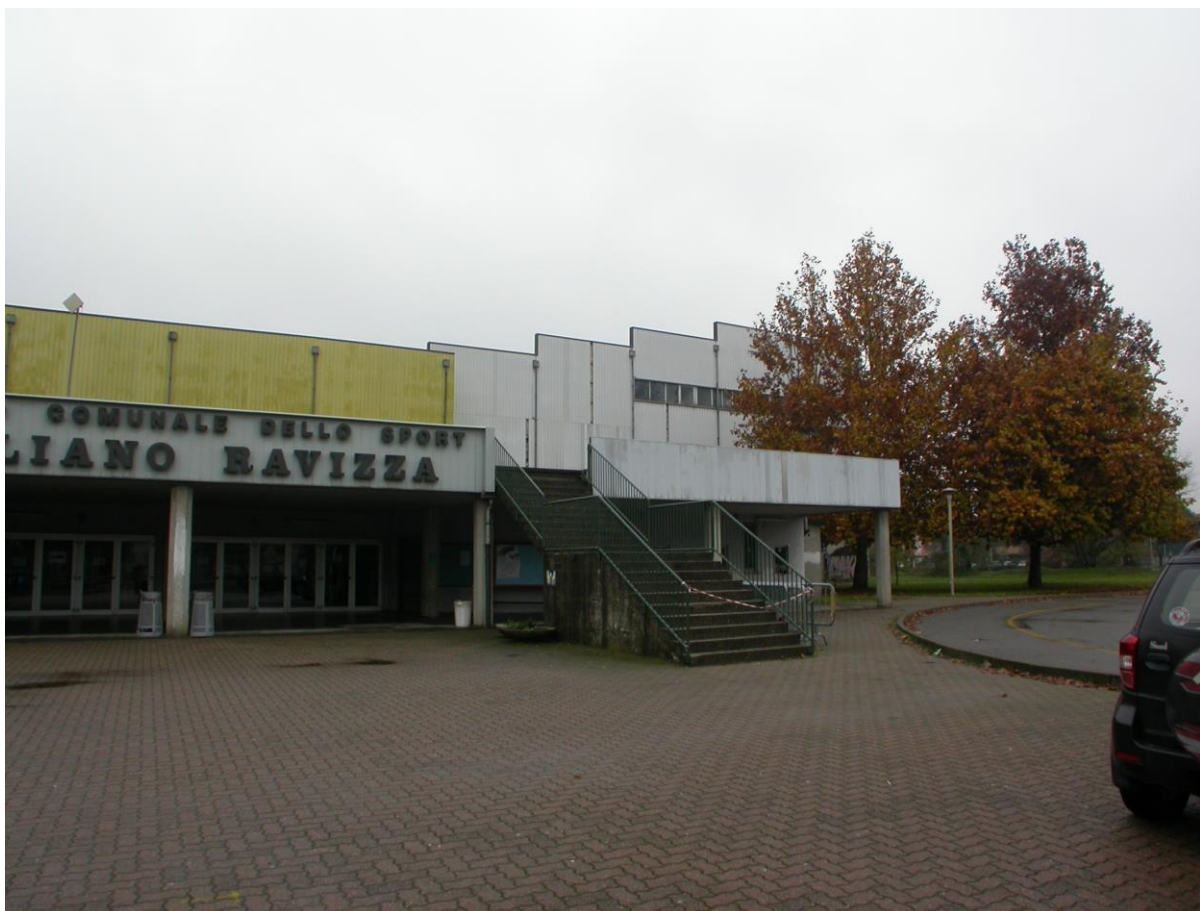
Foto n° 8 – PROSPETTO SUD-OVEST - Scala SX di accesso alla Terrazza
