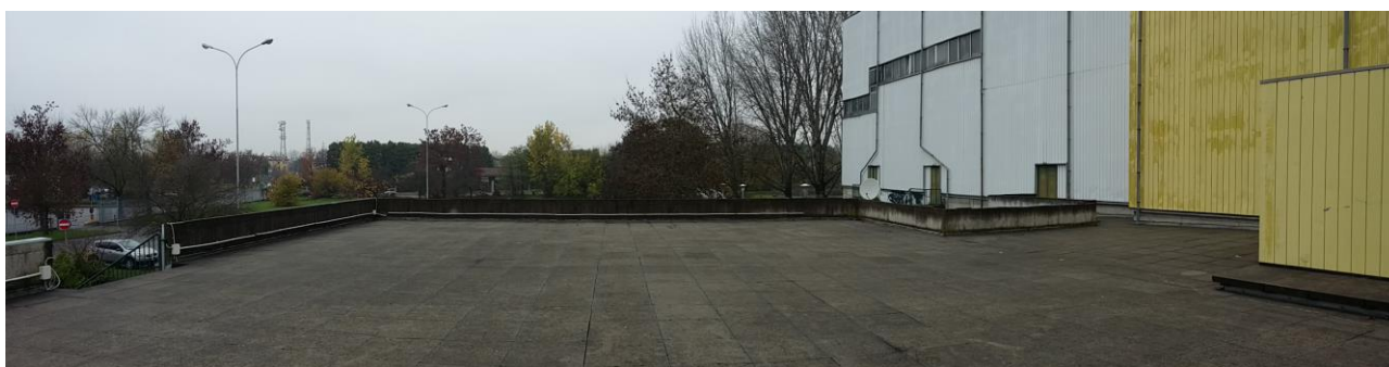
Foto n° 26 – Terrazza - vista lato NORD-OVEST
