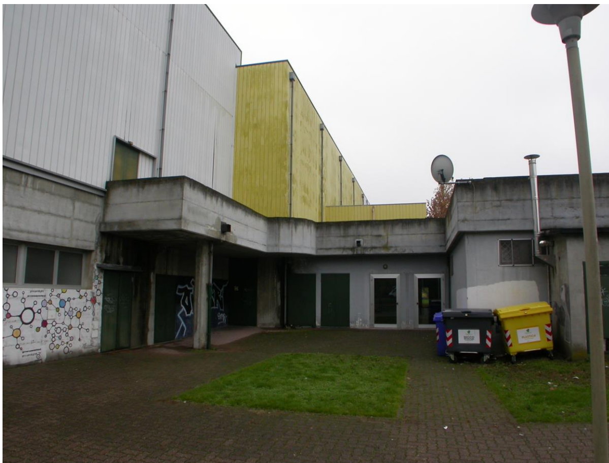
Foto n° 3 – PROSPETTO NORD-OVEST - part. collegamento Terrazza/Palazzetto
