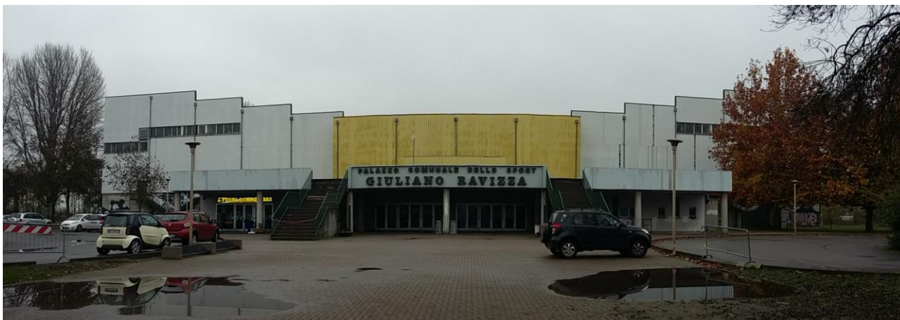
Foto n° 1 - PROSPETTO SUD-OVEST - Panoramica prospetto principale del Palazzetto
