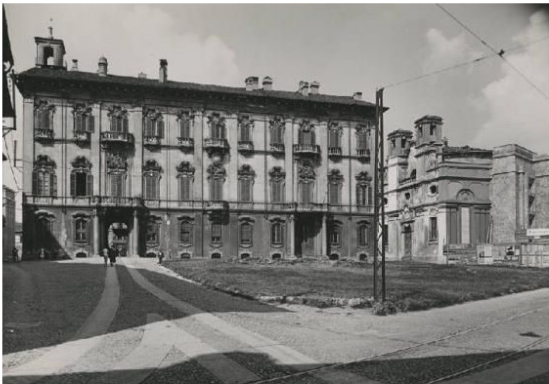
f.3 ) immagine del 1930 dove si nota il cantiere del nuovo edificio comunale
