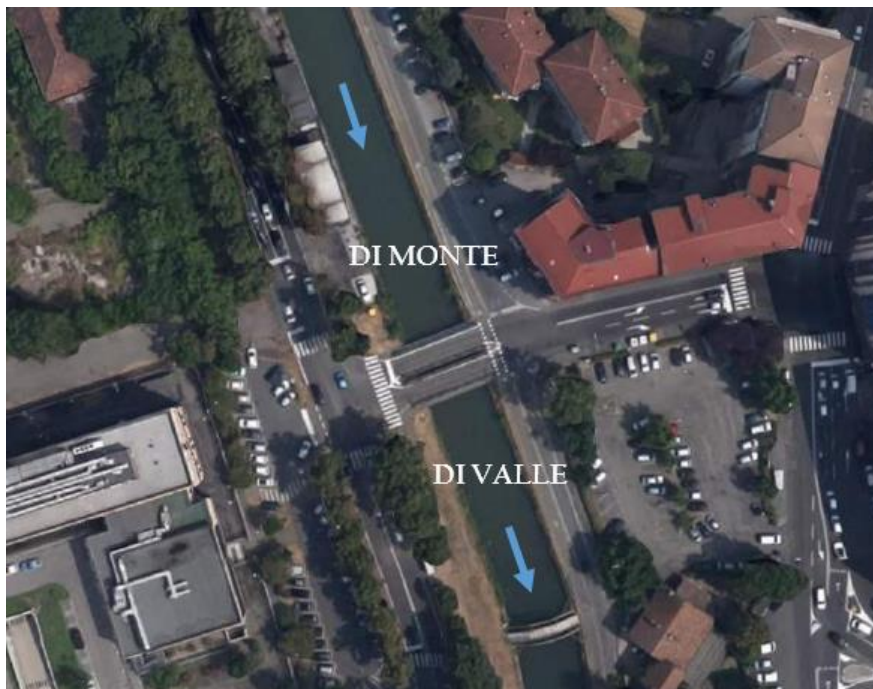
Figura 1: Vista aerea ponte esistente
