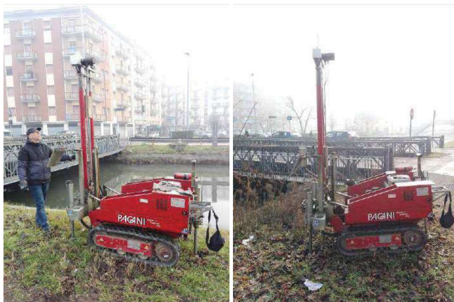
Esecuzione delle prove penetrometriche
