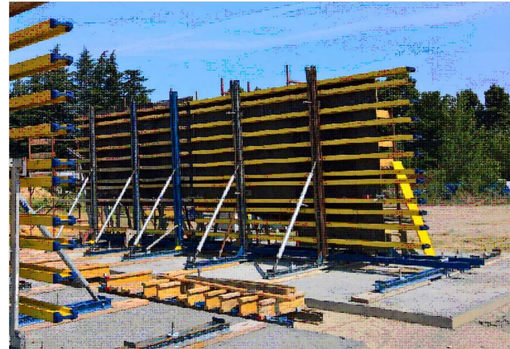
FOTO CANTIERE REALIZZAZIONE ELEMENTI PREFABBRICATI CON CASSAFORMA DOKA VISTA DALL'ESTERNO
