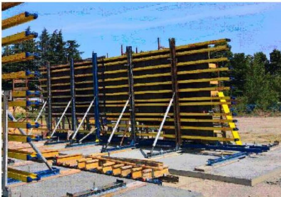
FOTO CANTIERE REALIZZAZIONE ELEMENTI PREFABBRICATI CON CASSAFORMA DOKA
