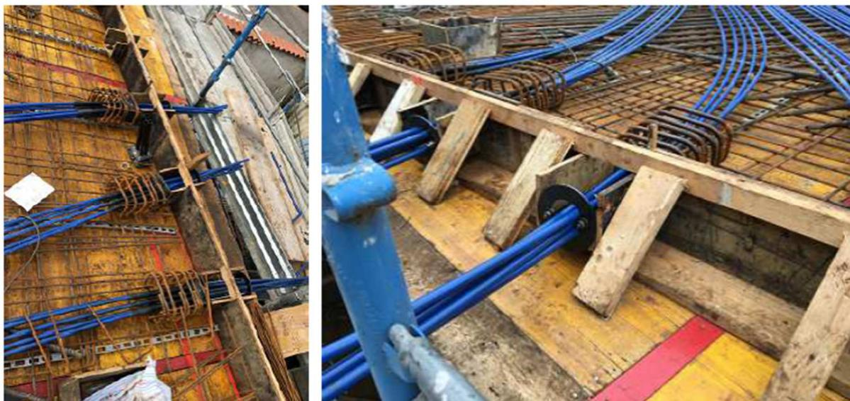
**Tutti gli ancoraggi, una volta tesati e tagliate le fruste di tiro dei cavi, non richiederanno di essere iniettati con grasso (non sono previsti tubi di iniezione o sfiato) ma sarà necessario solamente apporre gli appositi cappucci di protezione riempiti preventivamente con grasso (fornito in dotazione e in quantità paragonabile a un cucchiaino da the per ciascun cappuccio da installare sul singolo trefolo).**
