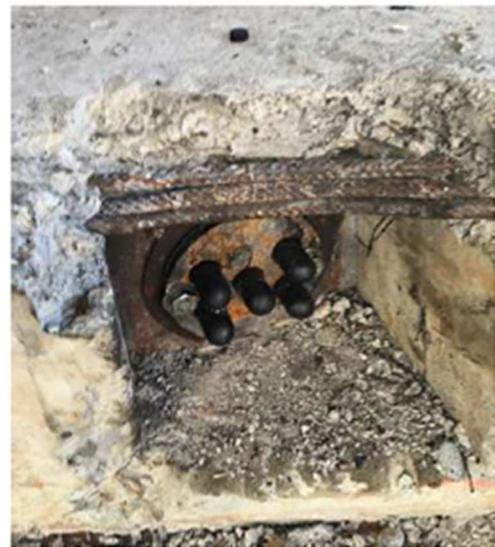
L'ancoraggio fisso viene posato direttamente nel getto e non necessita altro che l'installazione dell'armatura di frettaggio.
