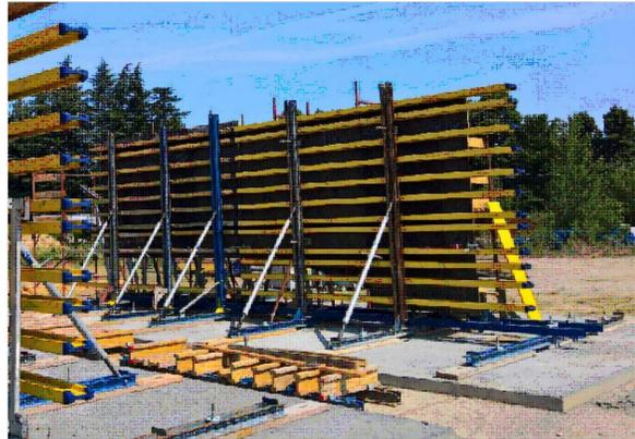
FOTO CANTIERE REALIZZAZIONE ELEMENTI PREFABBRICATI CON CASSAFORMA DOKA FASE INIZIO MONTAGGIO FERRO D'ARMATURA
