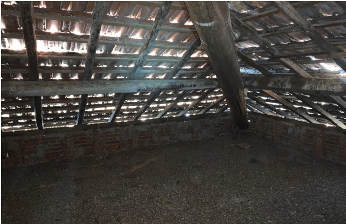
Figura 12- sottotetto palazzina B
