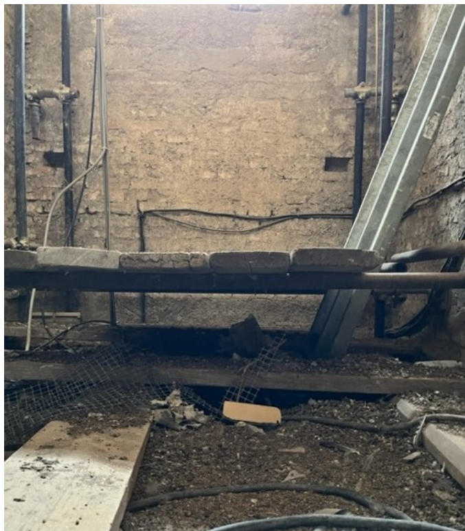
Fig. 18 - Vista interna del campanile: estradosso solai ligneo a quota 16,20 m
