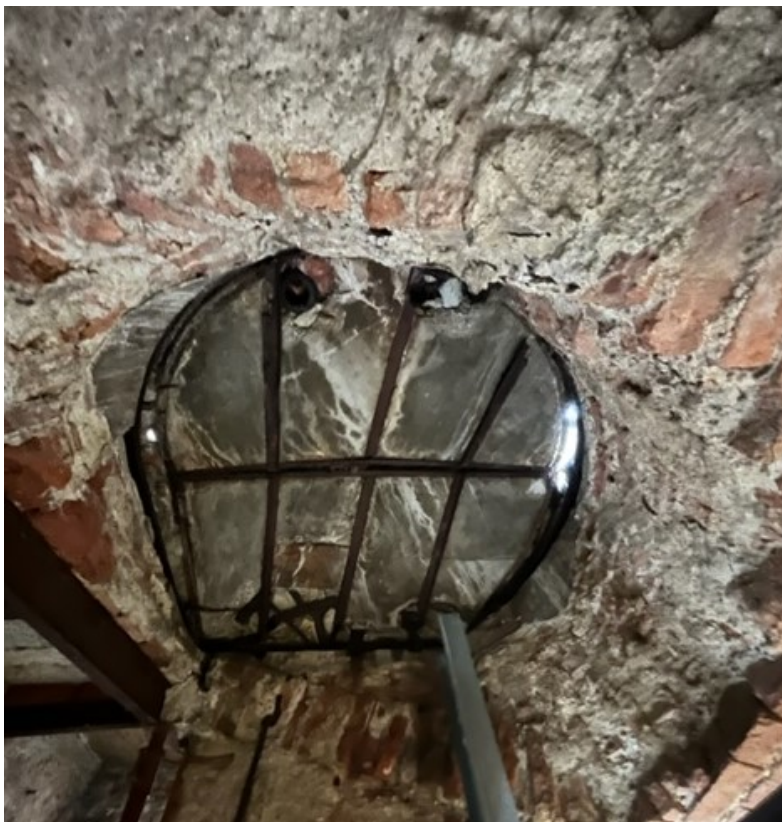
Fig. 21 - Vista della botola cella campanaria chiusa con soletta in putrelle e tevelle in laterizio
