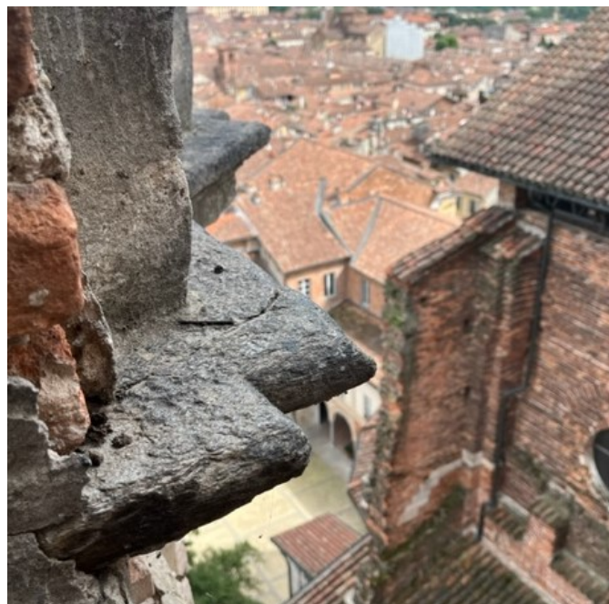
Fotografia n. 12 Dettaglio elementi in pietra esterni alla balaustra cella campanaria
