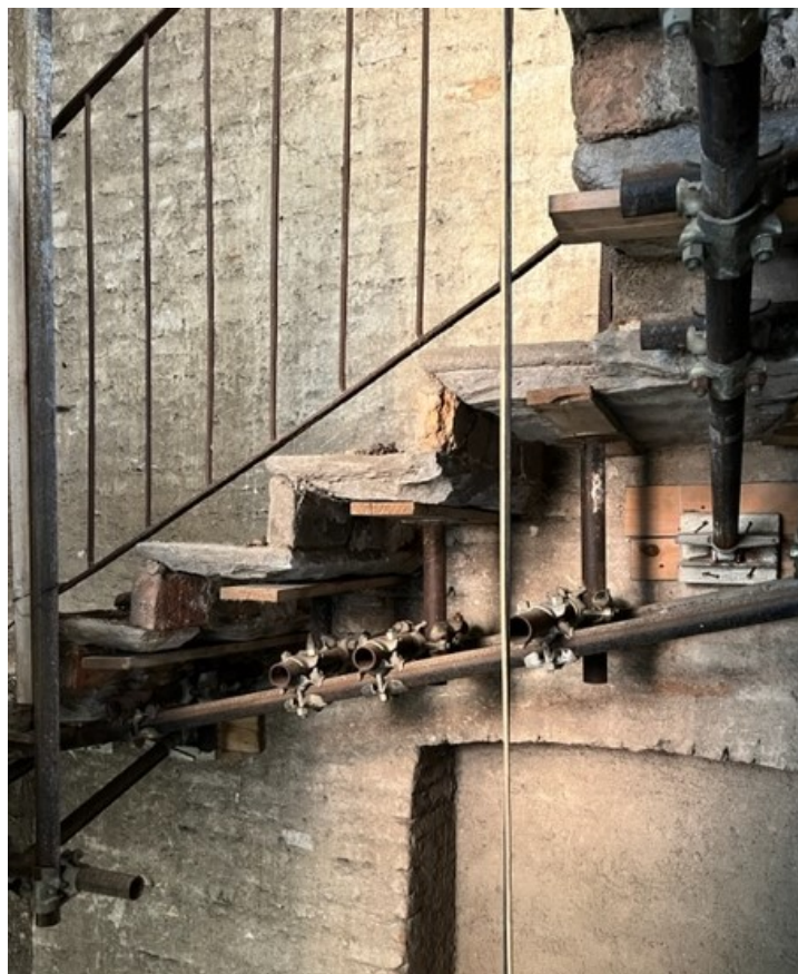
Fotografia n. 15 Vista interna: scala messa in sicurezza con puntelli metallici
