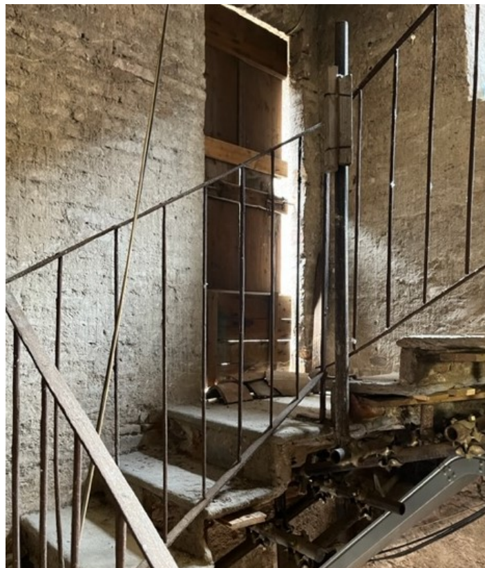
Fig. 20 – Vista del parapetto metallico della scala interna
