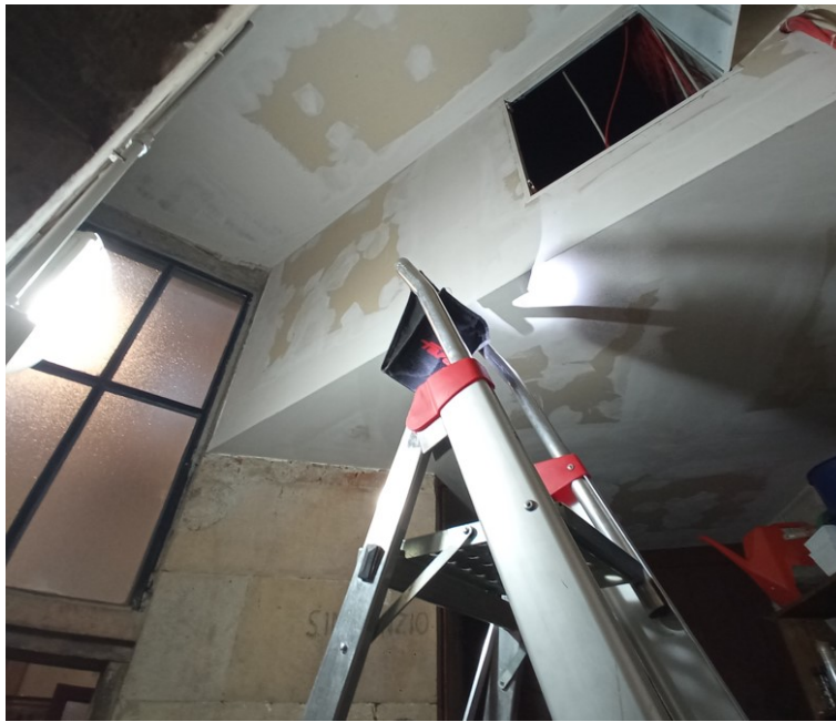
Fig. 16 - Vista interna del campanile: botola di accesso al solaio ligneo a quota 4,55 m
