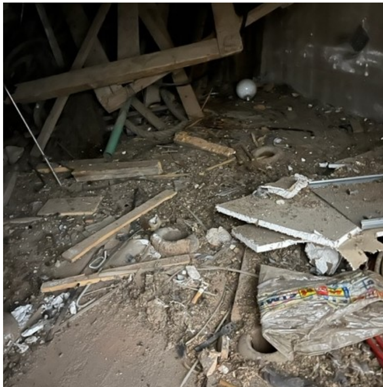
Fig. 17 - Vista interna del campanile: estradosso solaio ligneo a quota 4,55 m
