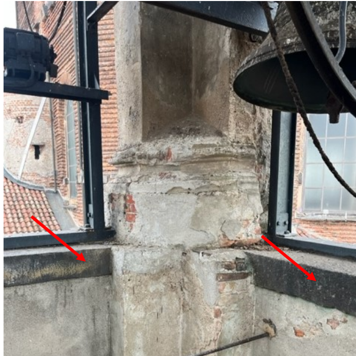
Fotografia n. 11 Dettaglio elementi in pietra interni alla balaustra cella campanaria
