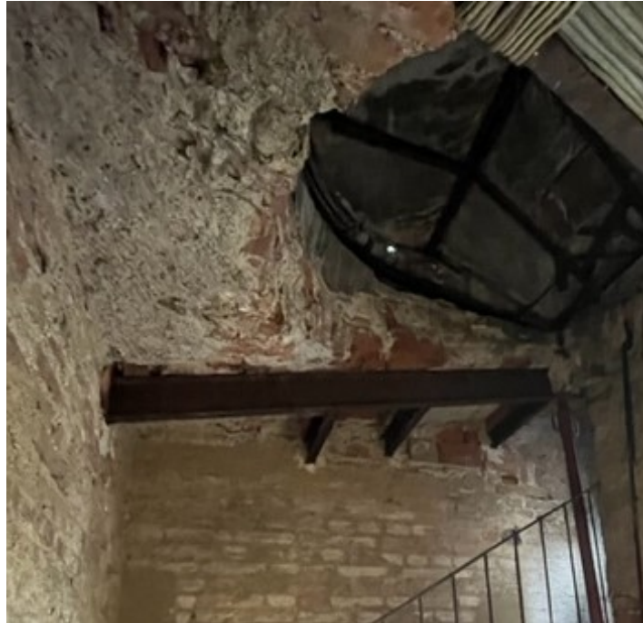
Fig. 19 - Vista dei profili metallici posti a consolidamento del solaio cella campanaria
