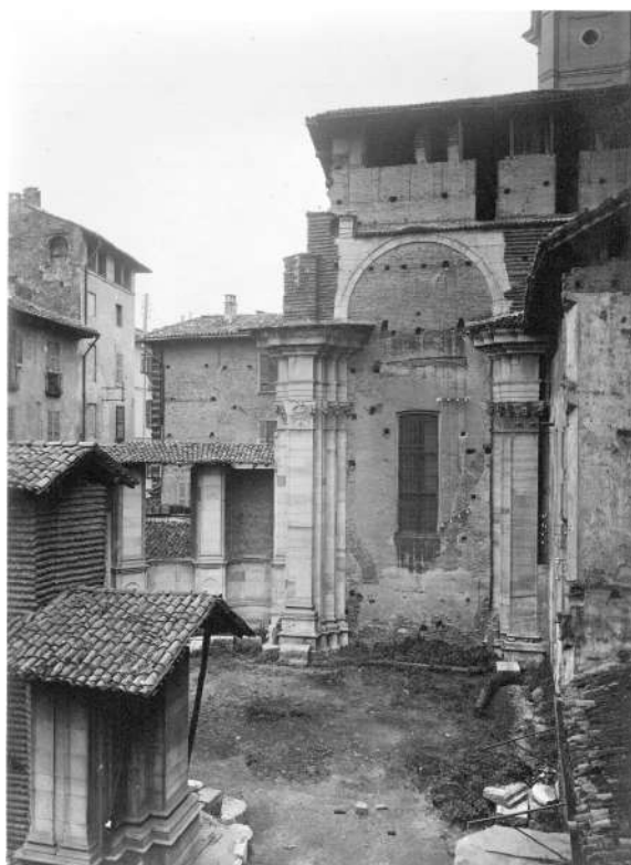
Fig. 4: La navata minore esistente verso il presbitero, eseguita nel 1665 e sulla sinistra l'abside
