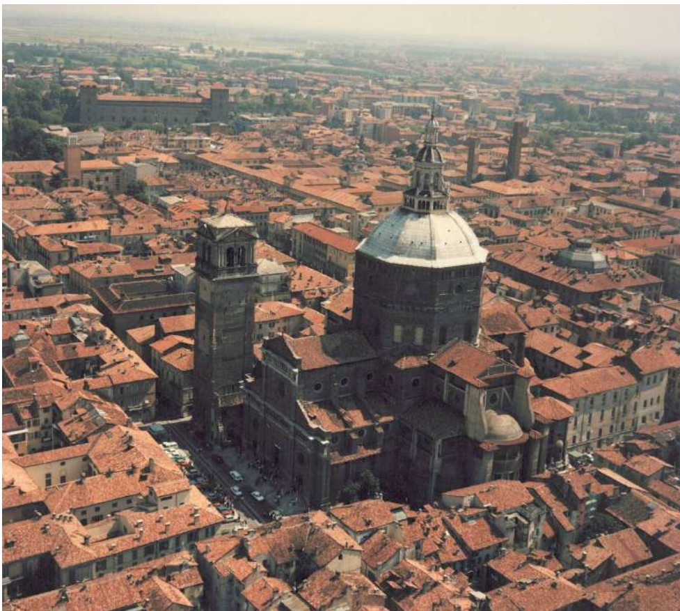
Fig. 4: Vista aerea del complesso monumentale completato
