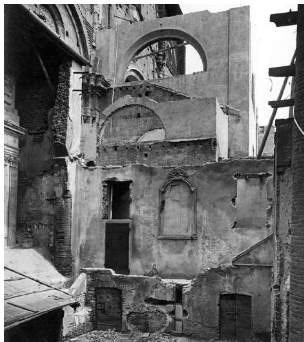
Fig. 10: Fasi della demolizione della cappella di Sant'Agostino che, costruita nel 1832 fu distrutta nel 1939.
