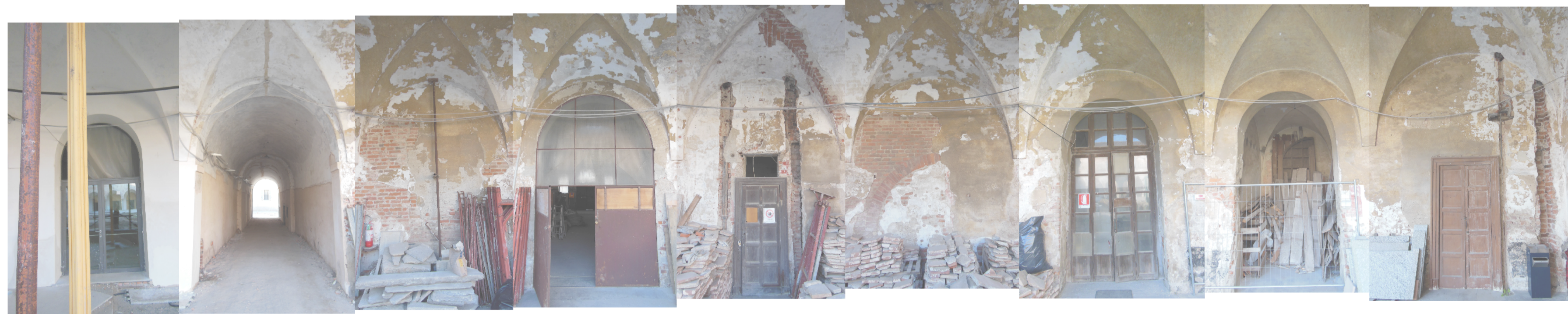
PARTICOLARI FOTOGRAFICI PORTICATO CHIOSTRO
