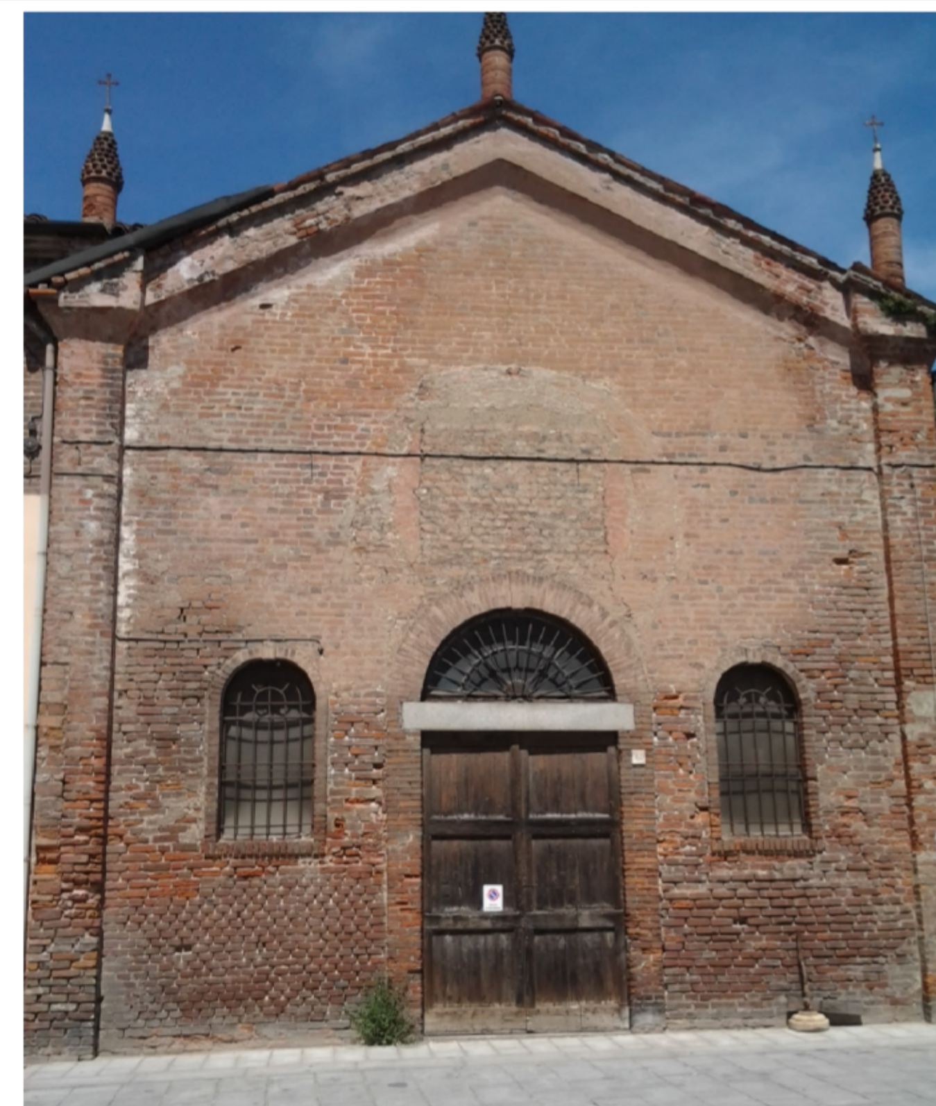
FACCIATA - PARTICOLARE FOTOGRAFICO STATO ATTUALE
