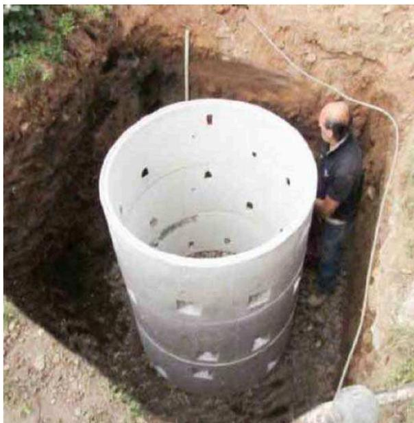
**Fig.13:** Scavo ed esempio di posa degli anelli drenanti
