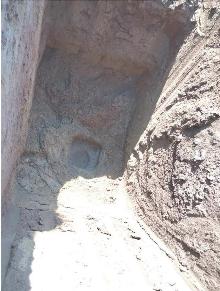
**Fig.6:** Prova di permeabilità sul fondo della trincea Tr1
