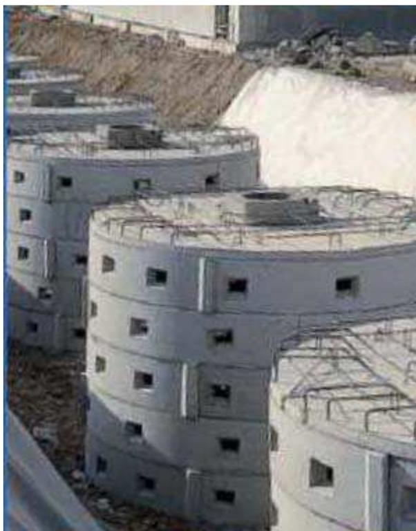
**Fig.12:** Esempio di pozzi disperdenti posti in linea
