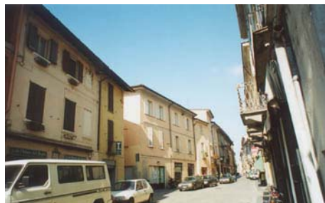
la stessa tinteggiatura su edifici diversi non è in genere un intervento coerente ed può appiattare la prospettiva stradale
