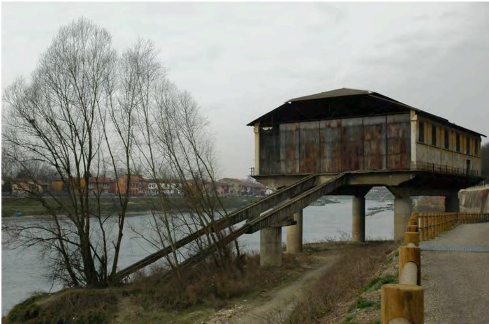
Dettaglio dell'Idroscalo (fonte sito web Wikipedia). Costruito su pilotis negli anno '20, insiste planimetricamente in Fascia fluviale A del Pai, ma sia la basse della soletta su pilotis che il piano capestabile, risultano, come evidenziato in foto, ad un quota ben superiore del piano stradale di Lungo Ticino Visconti, non inondabile e superiore all'altezza idrometrica della piena di riferimento.
