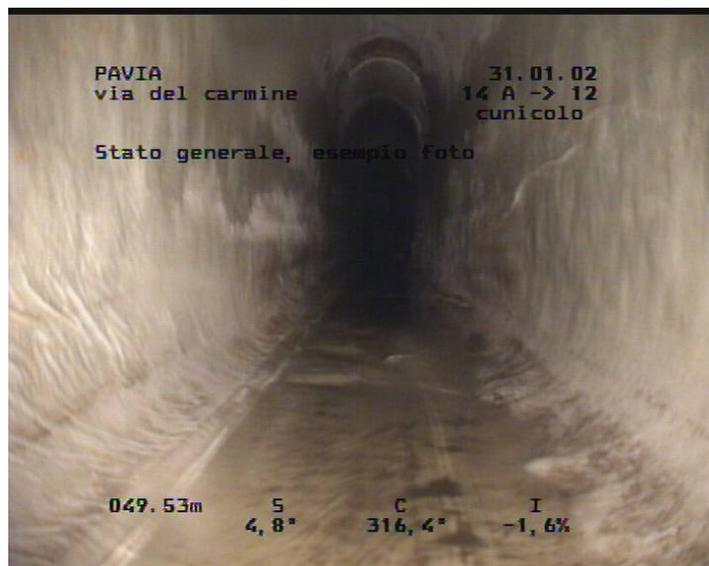
**Foto – video ispezione fognatura consolidata con tecnica relining**
