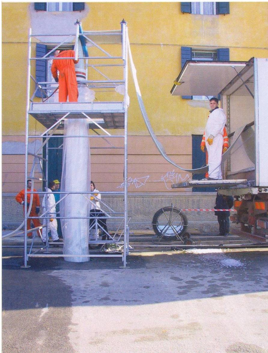
I lavori finora realizzati hanno previsto l'utilizzazione di rivestimenti in spessori variabili tra 16 e 22 mm con diametri equivalenti in alcuni casi prossimi ai 150 cm.
