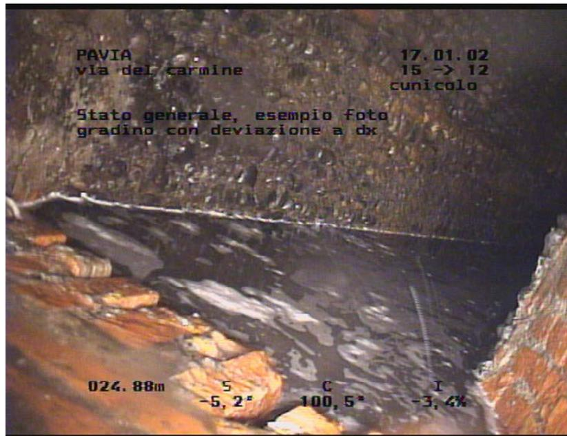
Foto - Pavia, via del Carmine – Gradino e deviazione a destra
