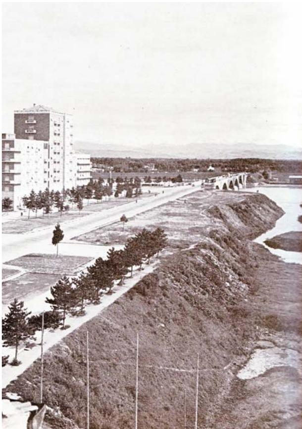
**Foto - La scarpata delle opere difensive del Bastione della Molazza e di sottofondazione dello stesso, dopo la demolizione delle opere murarie; si noti la differenza di quota tra il viale , quinta occidentale dell' asse viabilistico di circonvallazione, centrato sul ponte della libertà, e il livello naturale del terreno, con la presenza di pozze d'acqua. Tutta l'area sarà occupata dai palazzi di viale della Libertà.**
