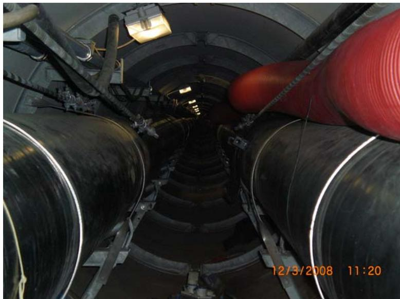
**Foto - Disposizione delle condotte internamente alla galleria – Fonte: ASM**
