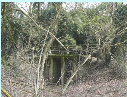
il ponte sulla roggia poco prima dell'immissione del ruscello Sorgente
